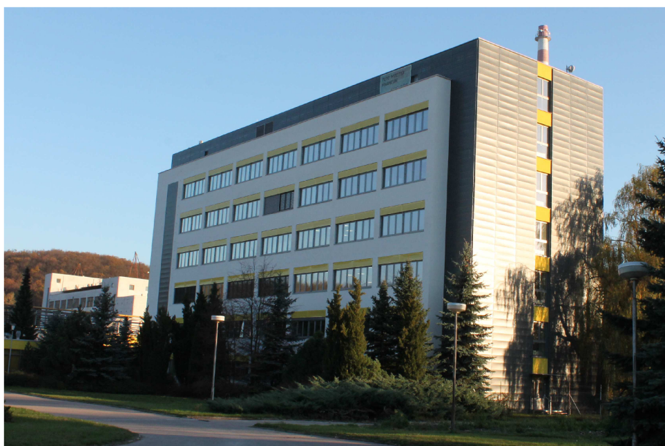
Laboratorní budova společnosti BioVendor – Laboratorní medicína a.s.
