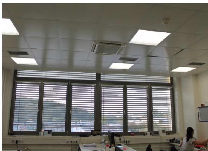
Umístění přívodních distribučních elementů VZT
