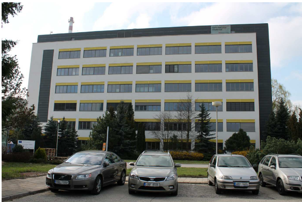
Rekonstrukce systémů vzduchotechniky pro 3.NP laboratoří společnosti BioVendor – Laboratorní medicína a.s.
