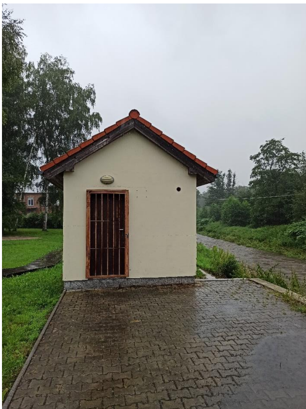
Příloha č. 11: Vodoměrná stanice Hrádek nad Nisou
