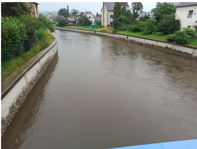
Příloha č. 10: Koryto Lužické Nisy v Hrádku nad Nisou – centrum (foceno: 17.8.2021)
