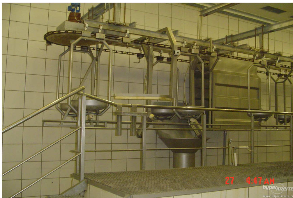
Obr. 17 Porážková hala - detail
