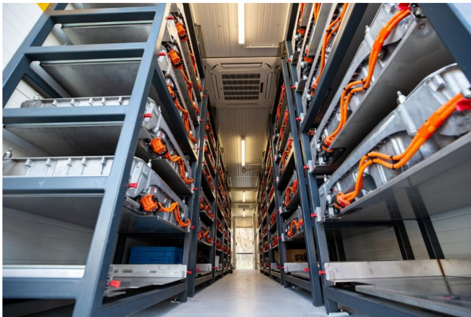
Obrázok 10 Úložisko z použitých batérií MAN [36]
