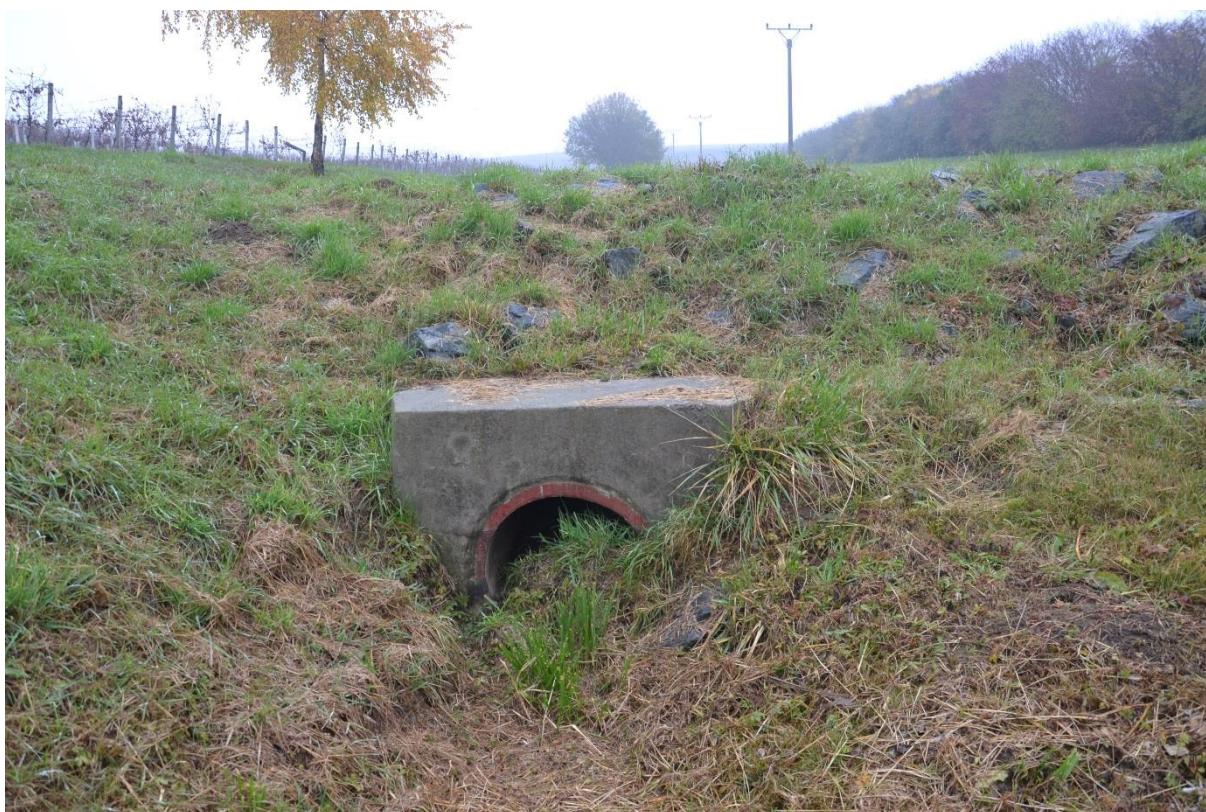
Obrázek 4.14 - Hráz suchého poldru u kritického bodu č. 5
