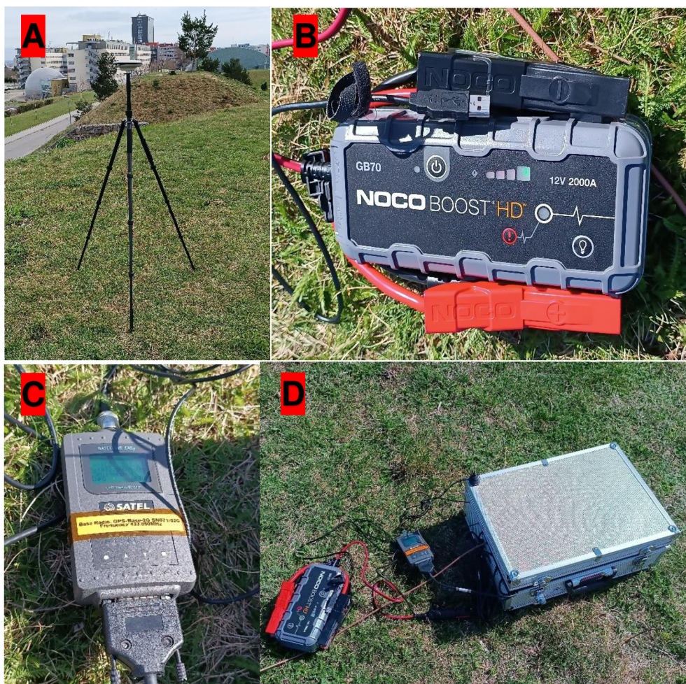
Obr. 31 A) Bázeová stanice, B) Napájecí zdroj, C) Základní rádio, D) Baterie, anténa a rádio
