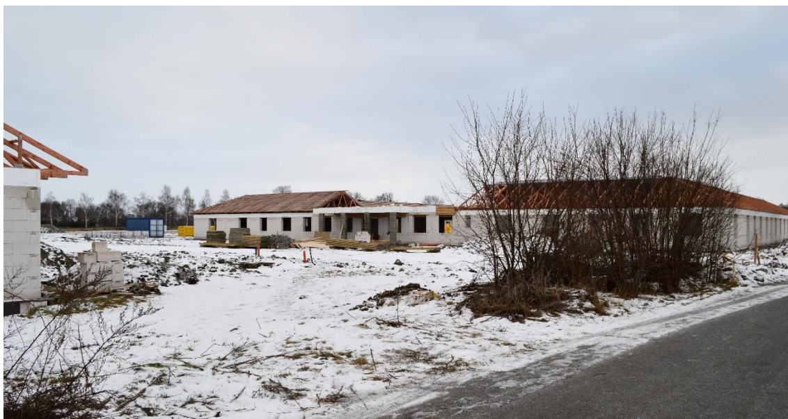
Obr. 4-37 Stav výstavby bytového komplexu pro seniory v lednu 2019 [Zdroj: vlastní zpracování]
