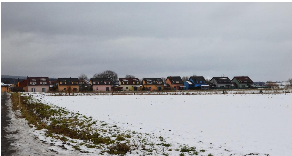
Obr. 4-20 Typová zástavba RD v obci Bukovany [Zdroj: vlastní zpracování]
