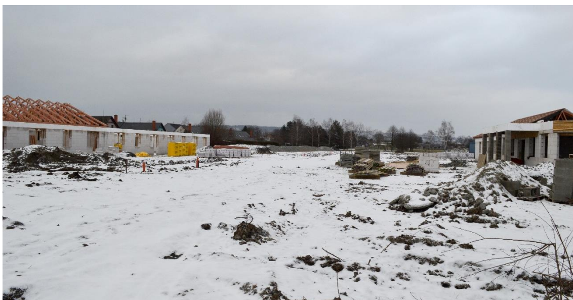
Obr. 4-38 Stav výstavby bytového komplexu pro seniory v lednu 2019 II. [Zdroj: vlastní zpracování]
