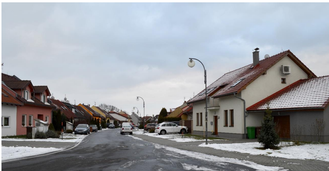
Obr. 4-29 Příklad výstavby v okrouhlém suburbii označeném jako plocha E [Zdroj: vlastní zpracování]
