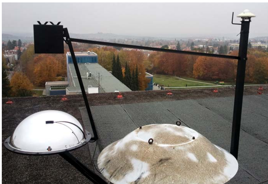
Obr. 45 – Konstrukce s rozpěrnou tyčí a pyranometrem
