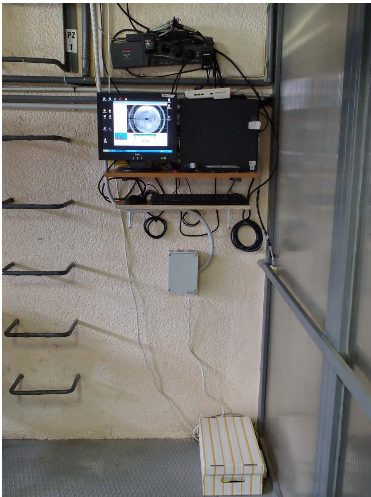
Obr. 53 – Technické zázemí po rekonstrukci
