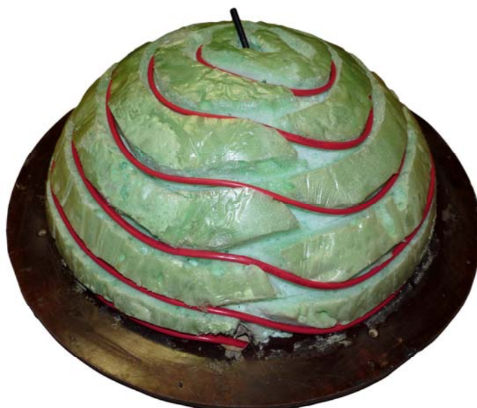
Obr. 42 – Topný kabel vložený do vyřezaných drážek
