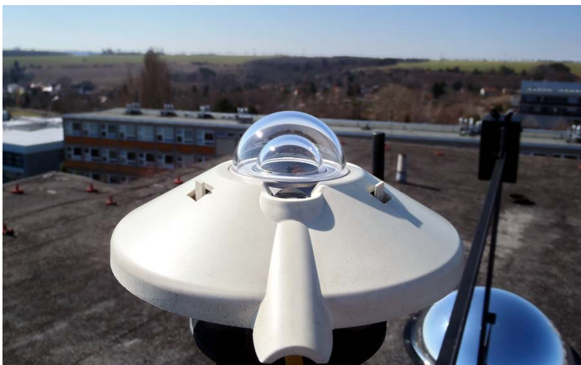
Obr. 57 – Pyranometr CMP 11 umístěný na střeše rektorátu ČZU
