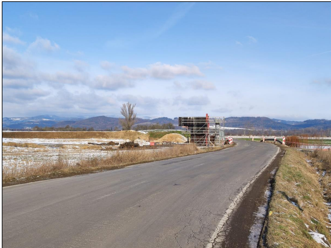
Obr. 51 Pokročilá výstavba silničního mostu přes silnici ve směru Chrovice (Hanáková, leden 2023)
