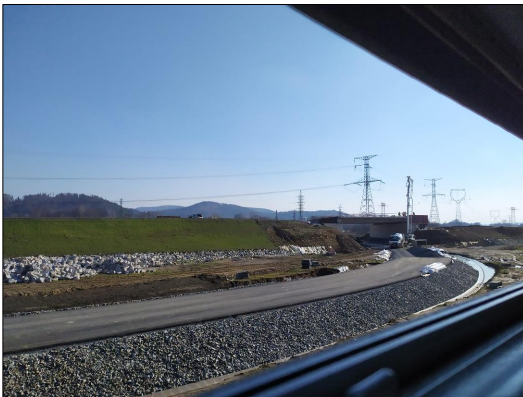
Obr. 48 Pohled na silniční obchvat I/44 a přívadeč ve směru Bludov (Hanáková, únor 2023)
