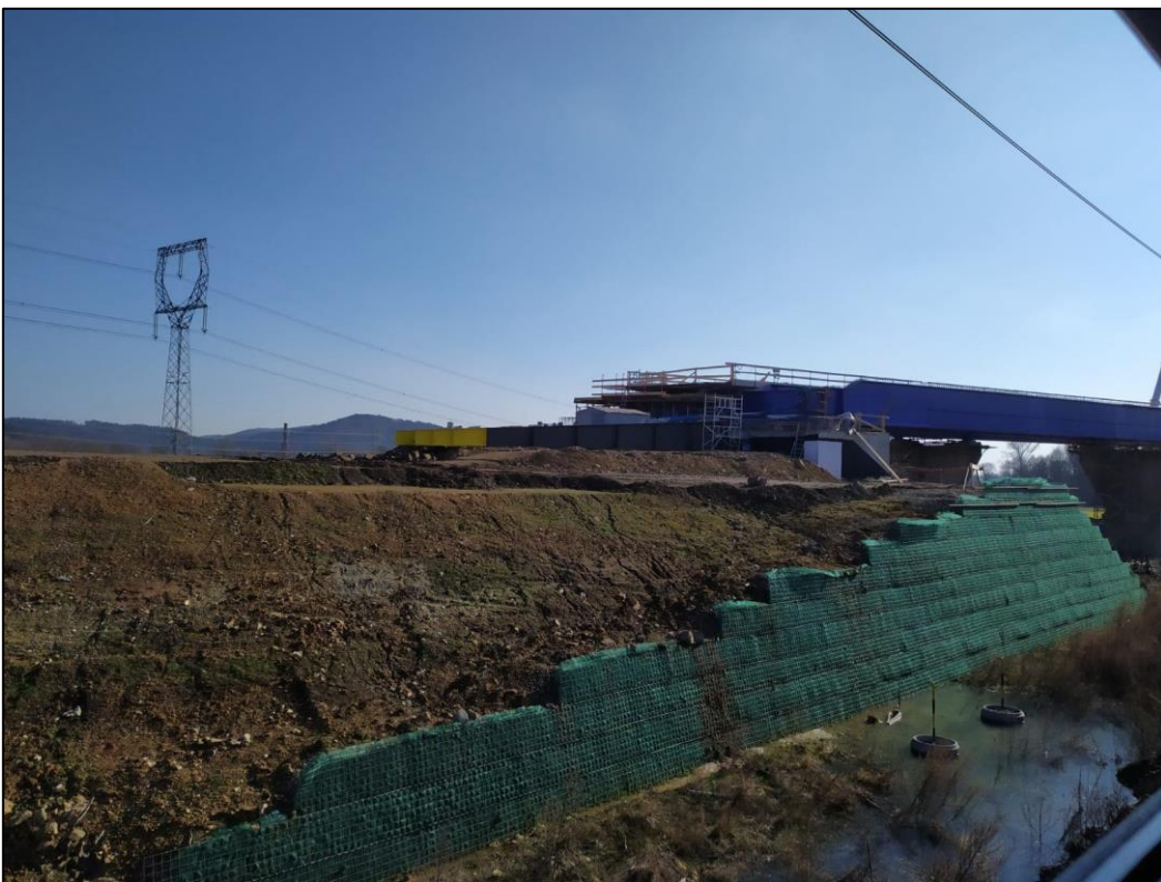
Obr. 47 Pohled na výstavbu silničního mostu přes železniční trať (Hanáková, únor 2023)
