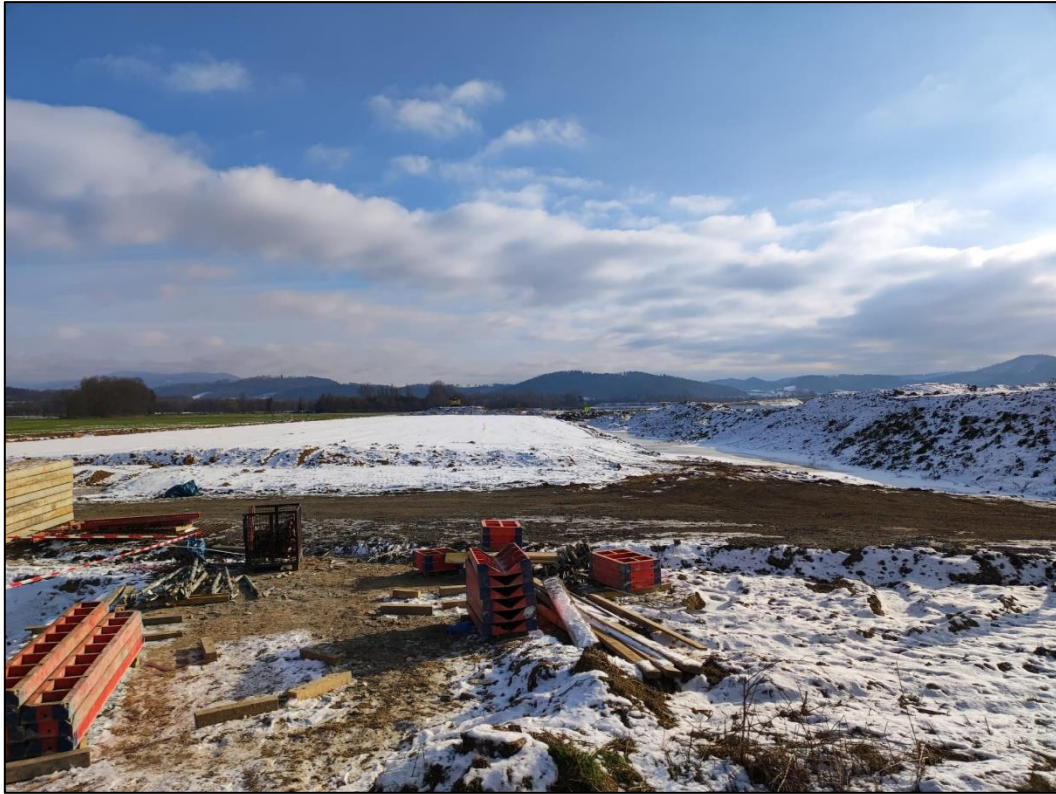
Obr. 52 Pokročilá výstavba silničního obchatu I/11 Postřelmov-Chromeč (Hanáková, leden 2023)
