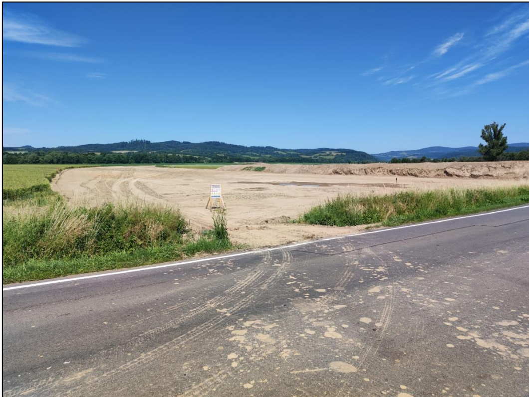
Obr. 50 Příprava silnice I/11 ve směru na Chrovice (Hanáková, červen 2022)
