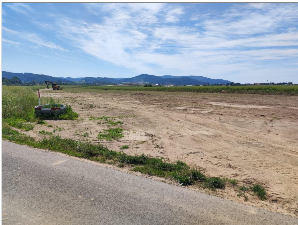
Obr. 49 Příprava silnice I/11 ve směru na Chromeč (Hanáková, červen 2022)
