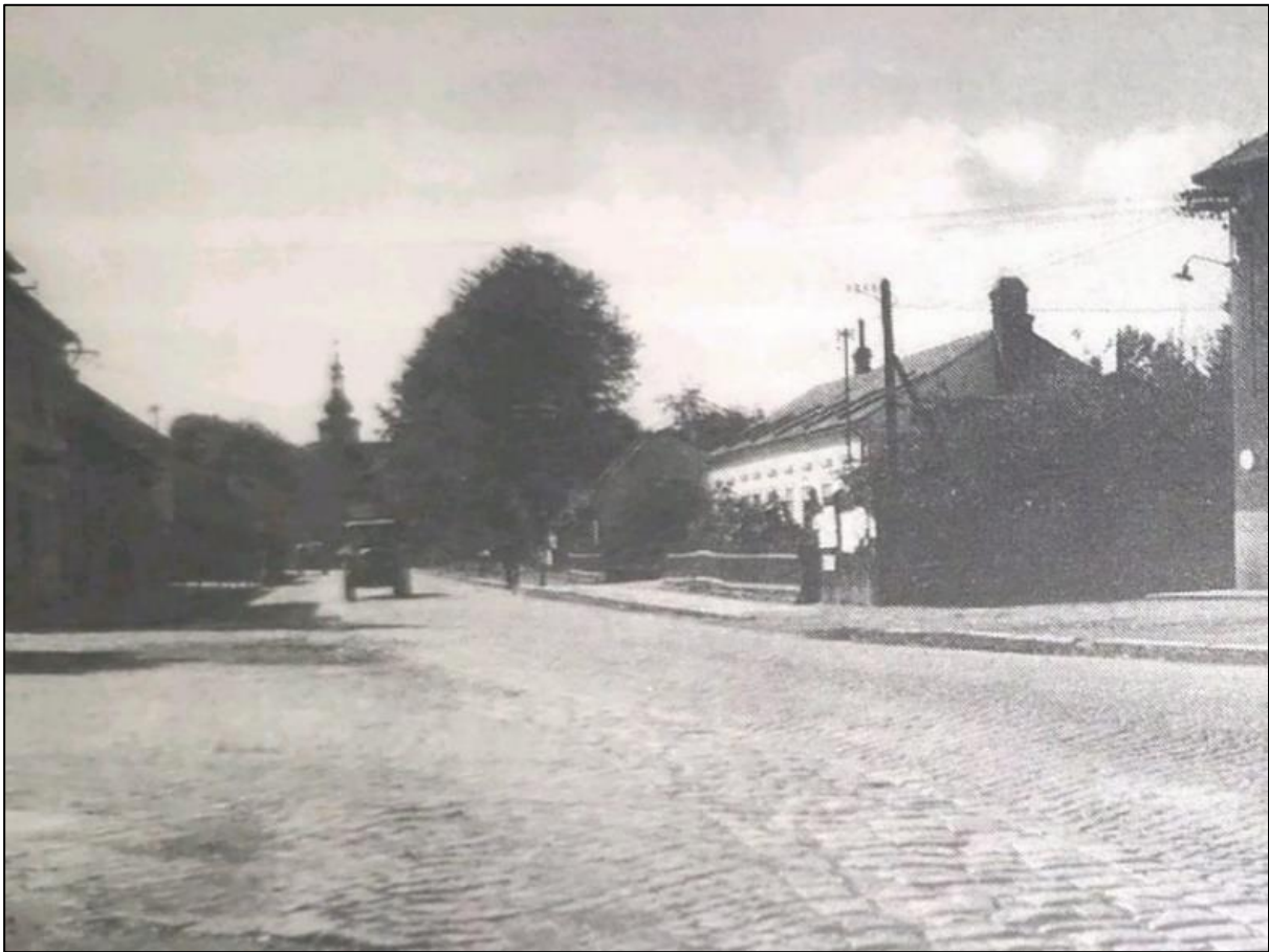
Obr. 12 Pohled na silniční síť v Postřelmově ve směru Zábřeh na Moravě v 60.-70. letech 20. století
