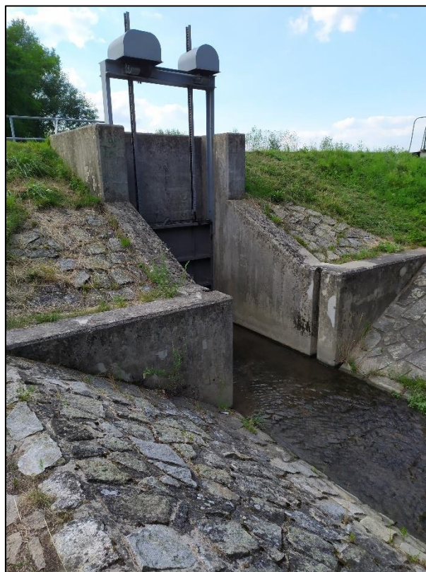
Obr. 60 Postřelmovský potok v místech výpustě do řeky Moravy (Hanáková, srpen 2022)
