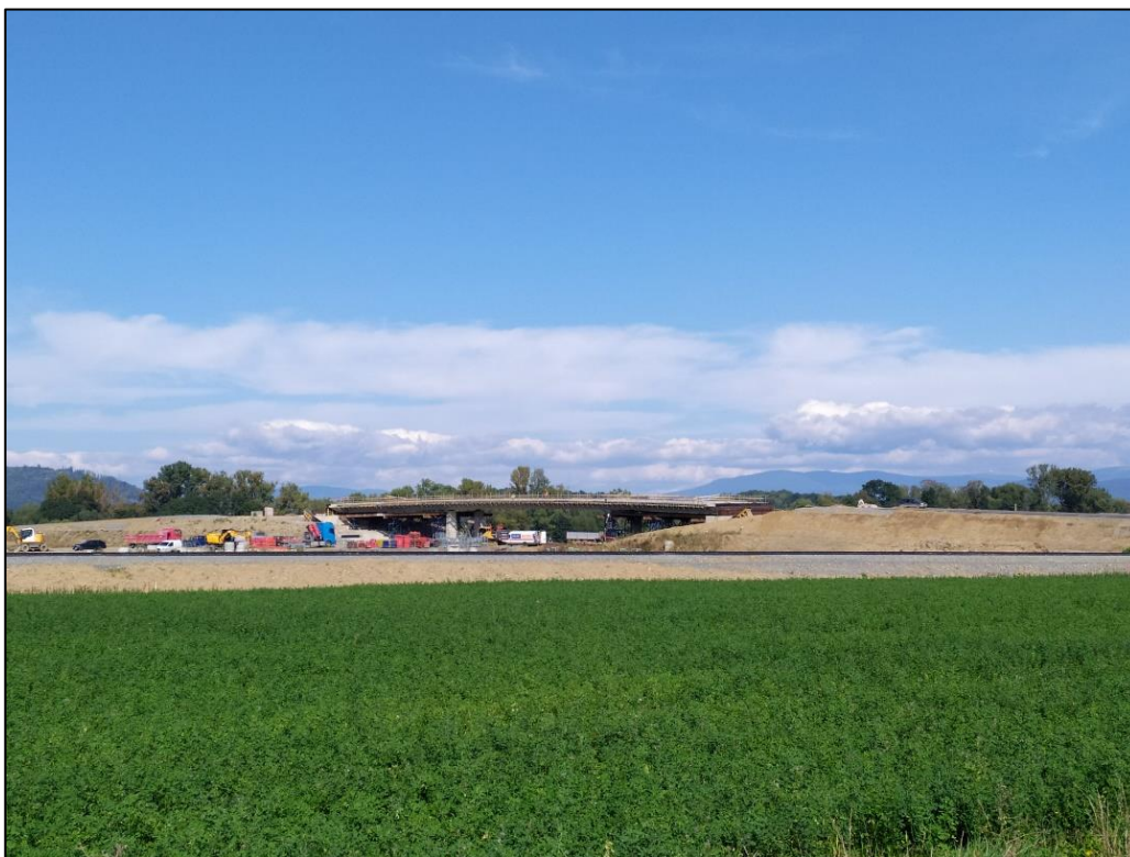
Obr. 45 Pohled na pokročilé práce na silničním mostu (Hanáková, září 2022)
