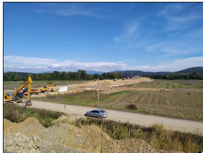
Obr. 43 Pohled na silniční násep obchvatu I/44 (Hanáková, červenec 2022)
