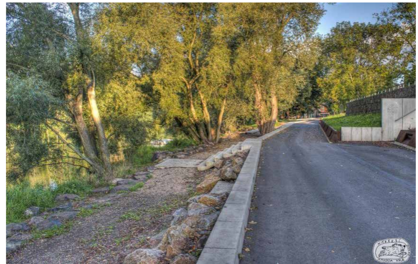
5. Nábřeží Maxipsa Fíka Pohled na zpevněnou cestu, která vede podél celého nábřeží a řešení přístupu k vodě.
