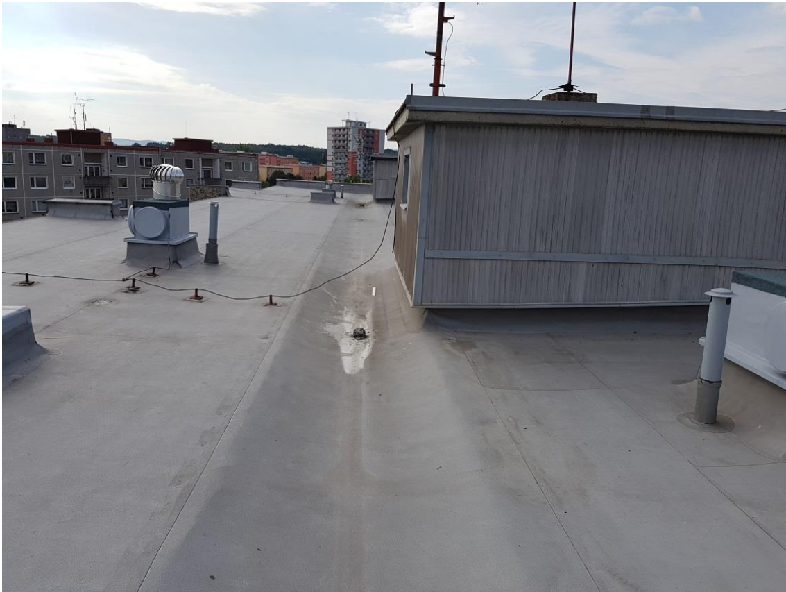
Obr.5 – Pohled na plášť střechy doplněný o větrací komínky.
