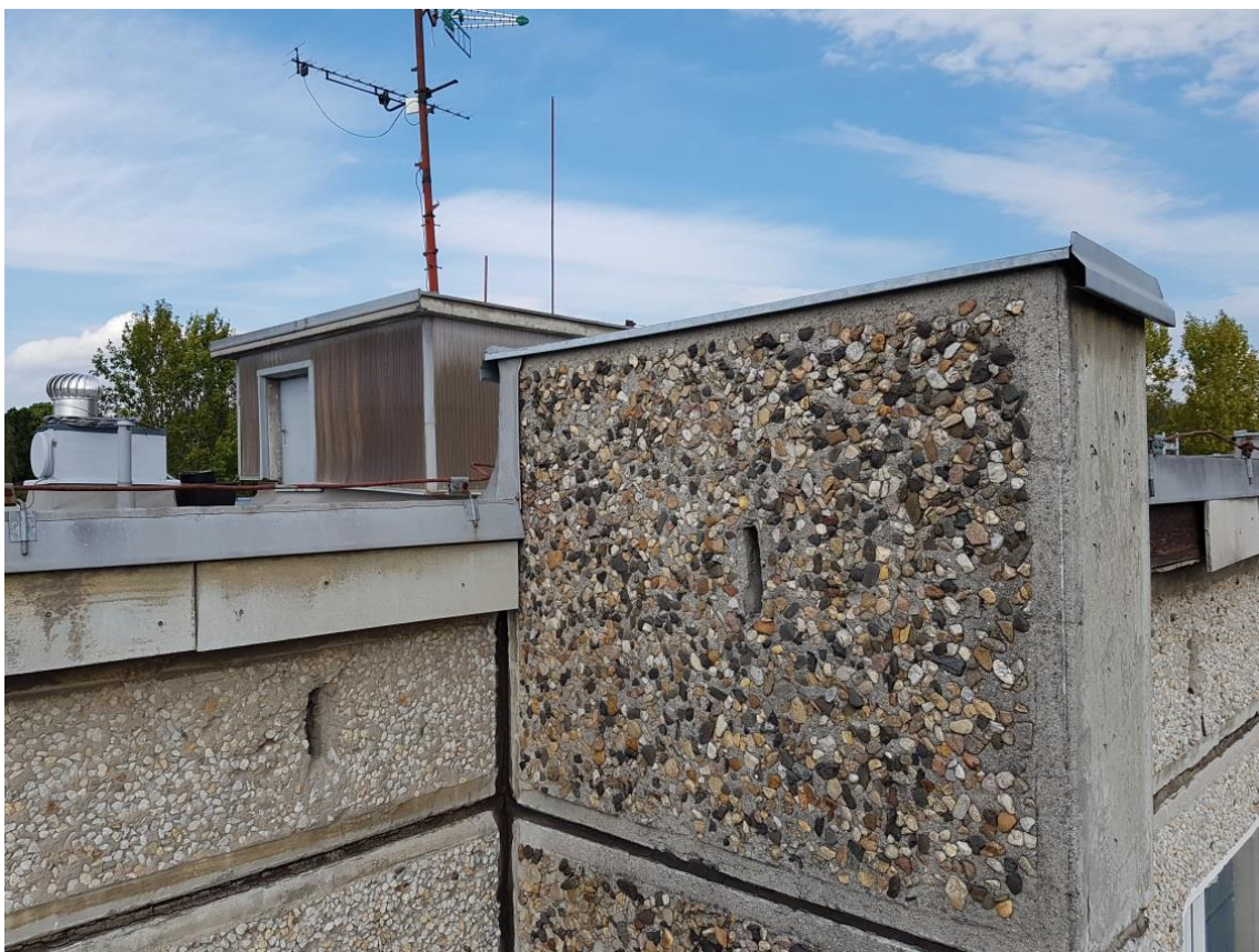
Obr.8 – Stávající větrací otvory.
