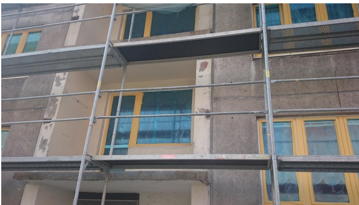
Obr.12 – Ochrana výplní otvorů před poškozením v průběhu stavby.
