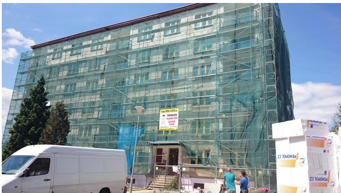
Obr.9 – Fotografie objektu před zateplením.
