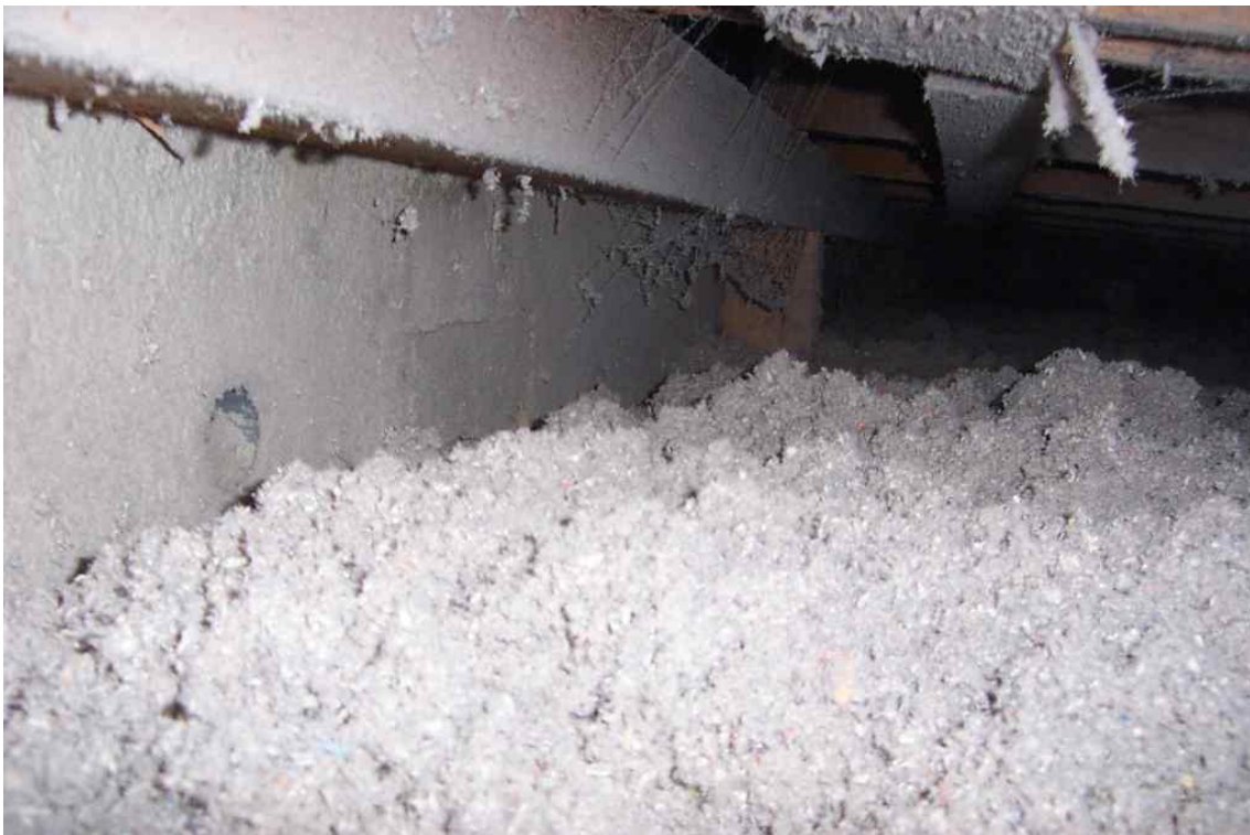
Obr.6 – Aplikace foukané izolace do konstrukce střechy.
