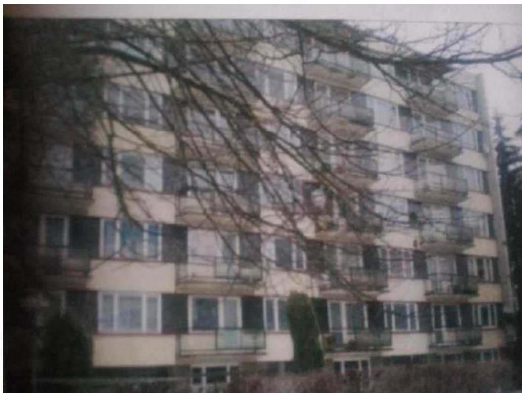
Obr.13 – Fotografie objektu před zateplením.
