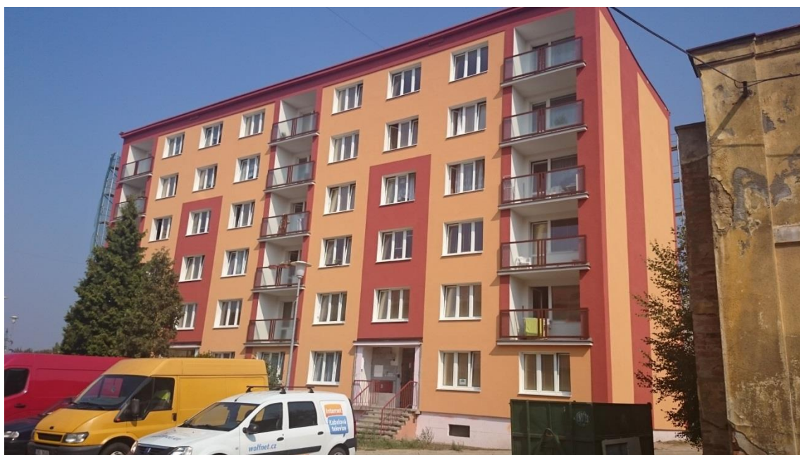
Obr.10 – Fotografie objektu po provedeném zateplení.
