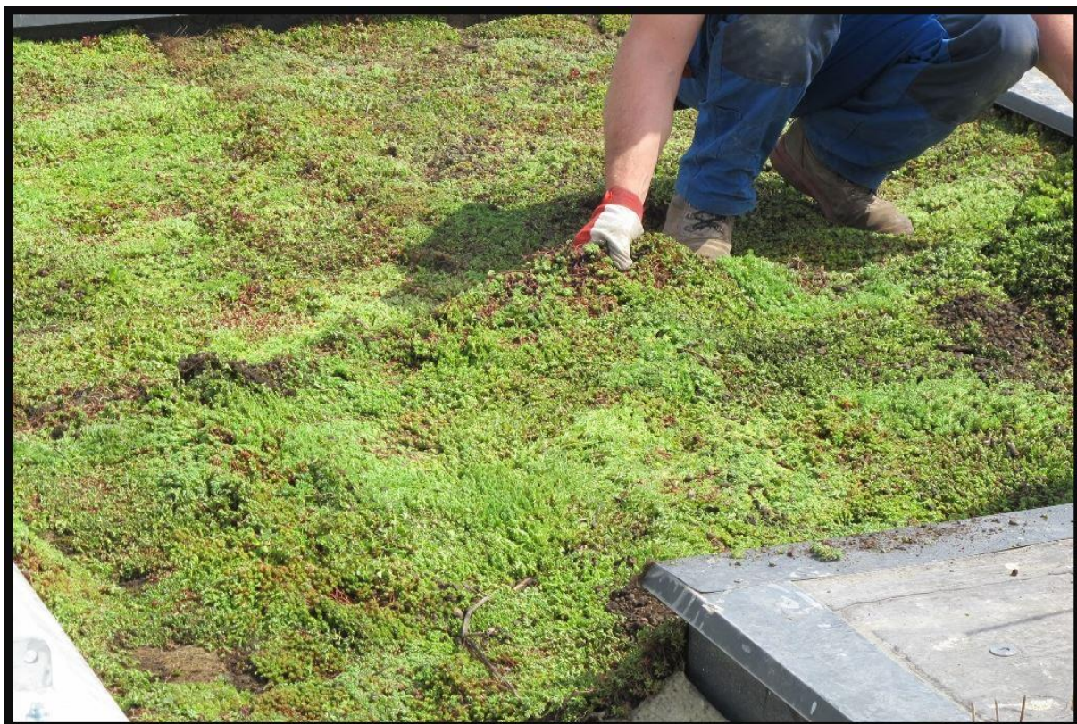
Obr. 15 – Instalace zelené střechy.
