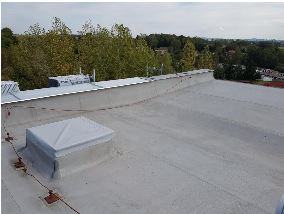
Obr.7 – Fotografie zaslepení vstupů do konstrukce střechy po aplikaci izolantu.
