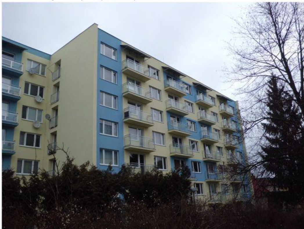
Obr.14 – Fotografie objektu po zateplení.
