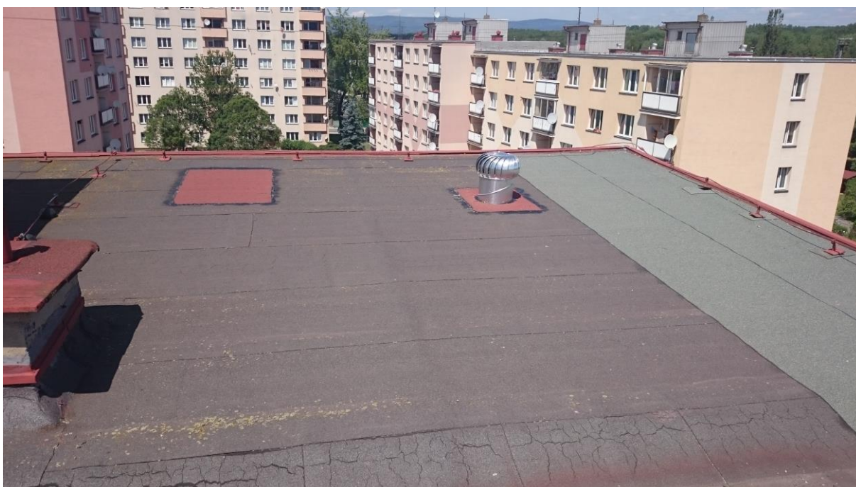
Obr.11 – Fotografie zaslepení vstupů do konstrukce po aplikaci izolantu a větrací hlavice.
