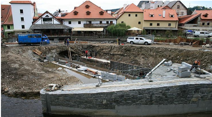
Obrázek 2 Přestavba jezu Jelení lávka (27)
