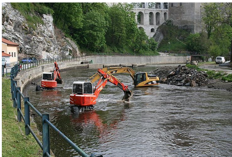
Obrázek 2 Prohrábka koryta řeky (27)
