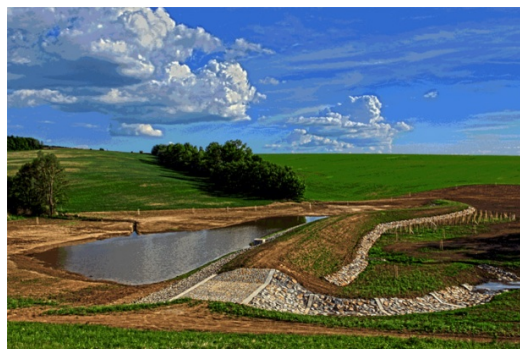
Obr. 16. Protierozní nádrž na Dobřínském potoce [Obr. 16]
