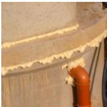
Obr. 19. Utěsnění trubky u betonové nádrže [Obr. 19]
