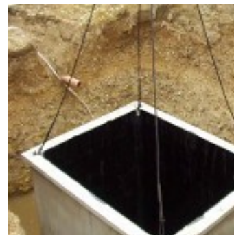
Obr. 21. Usazení betonové nádrže [Obr. 21]
