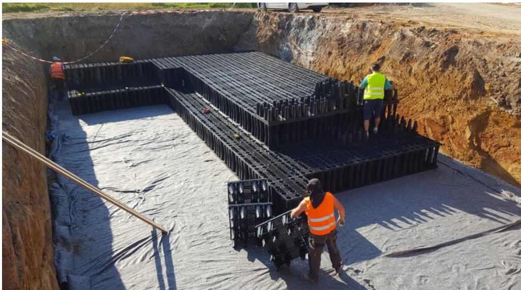
Obrázek 20: Vsakovací boxy – příklad umělého zasakování dešťových vod (URL18)
