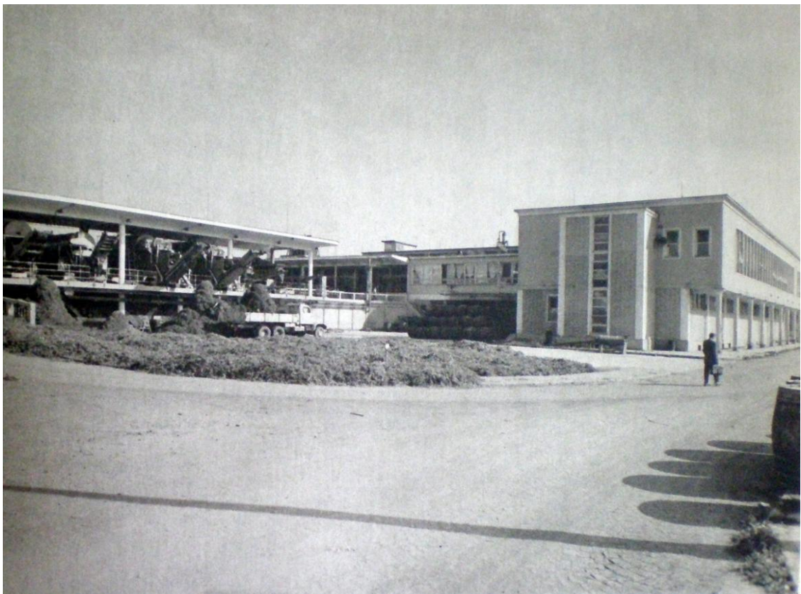
63 / Konzervárna, dokončeno 1956, demolice, foto: Václav Richter – Bohumil Samek – Miloš Stehlík, Znojmo, Znojmo 1966, obr. 95
