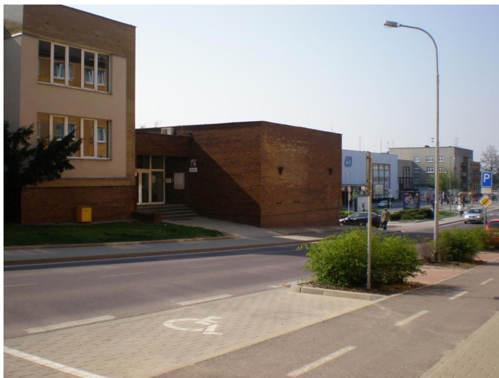
20 / Budova celní správy, 1988, foto: Monika Mažárová 18. 4. 2011
