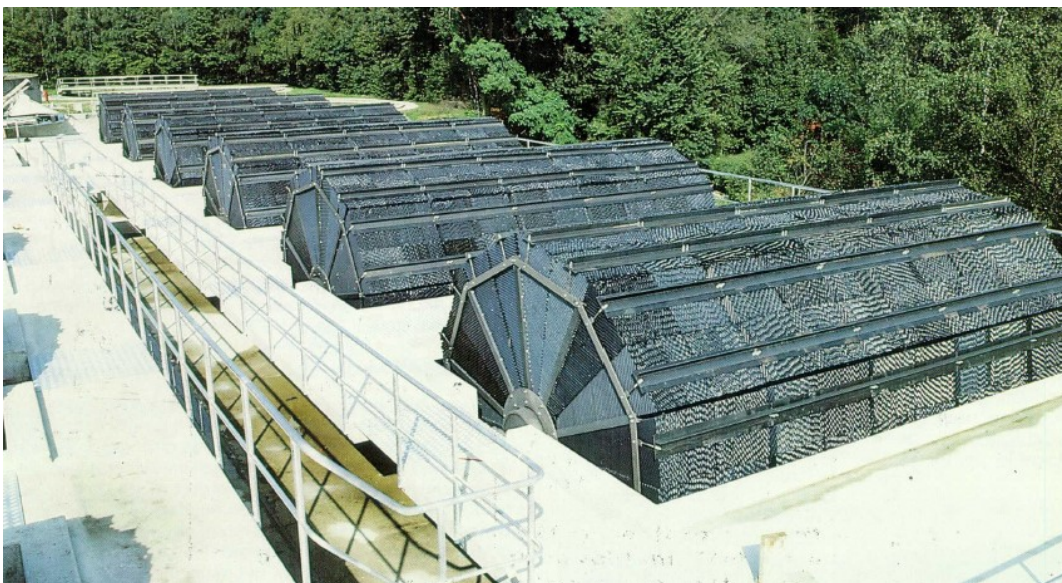
Obr. 4.5 Rotační diskové reaktory [3]
