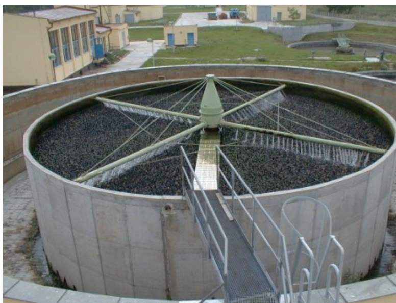
Obr. 4.4 Zkrápěná biologická kolona se Segnerovým kolem [17]
