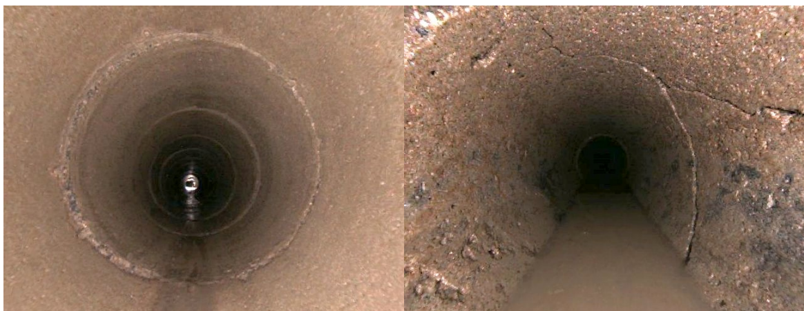
Obr. 8.2 Vnitřní pohled do stávající jednotné kanalizace [36]
