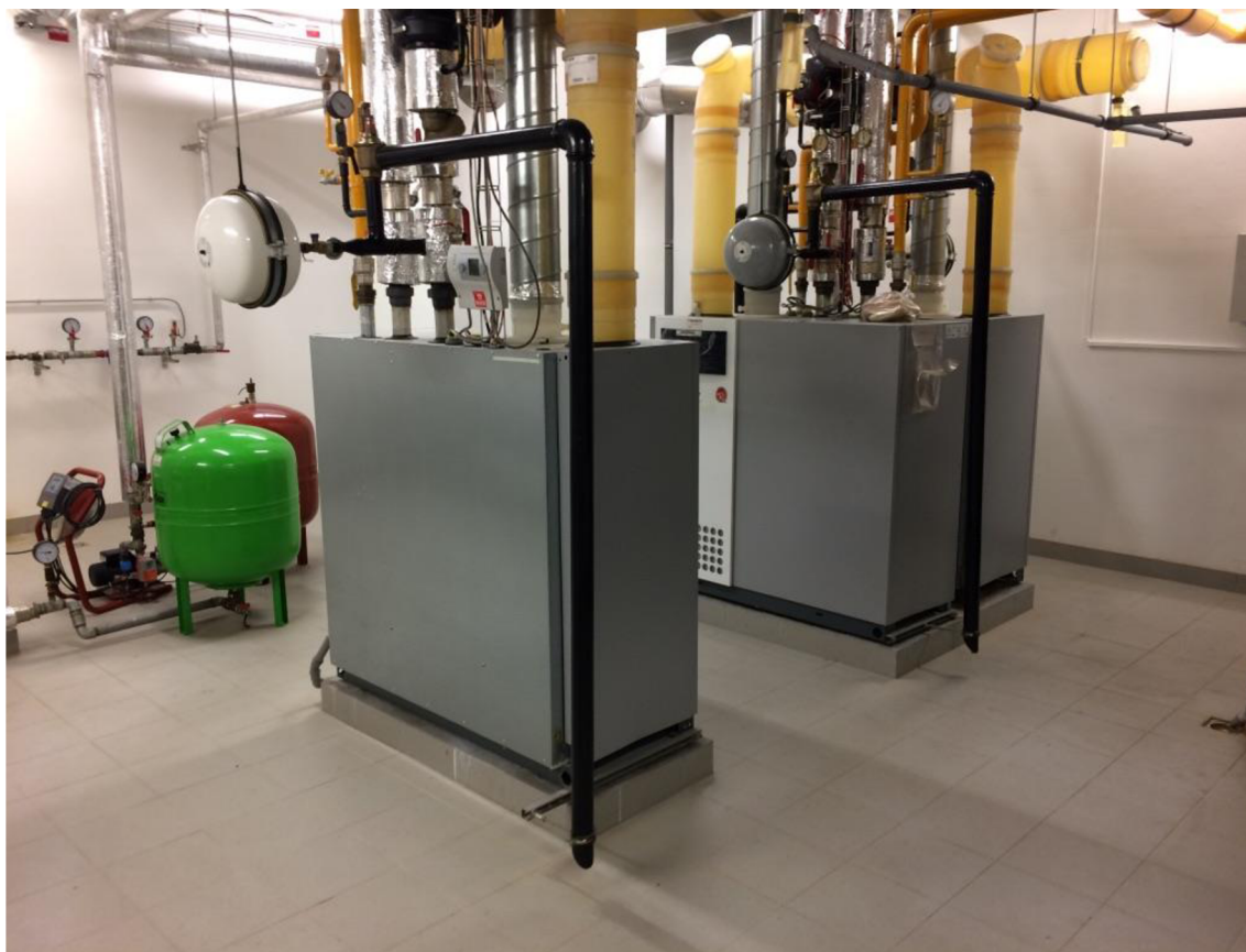
Obr. B 2: Stávající plynové kondenzační kotle WOLF – 3x 275 kW
