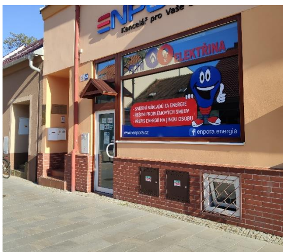
Obr. 24 Parter domu na ulici Dolní Váhy 1
