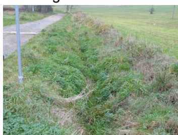
Obr. č. 3: Příkop na jižní části pozemku
