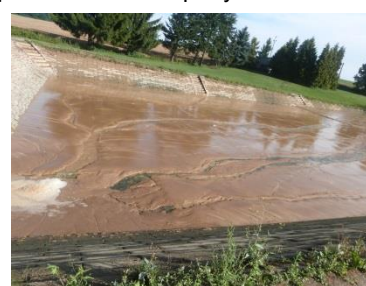
Obr. č. 6: Zanesená požární nádrž
