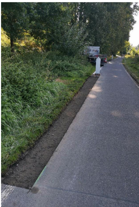
Obrázek 8: Úpravy povrchu, odstraňování starého asfaltu a instalace nového (foto Votava)
