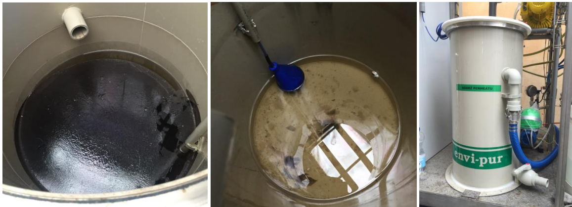
Obr. 28 Poloprovozní AnMBR - znečištění nádrže permeátu (foto autor)
