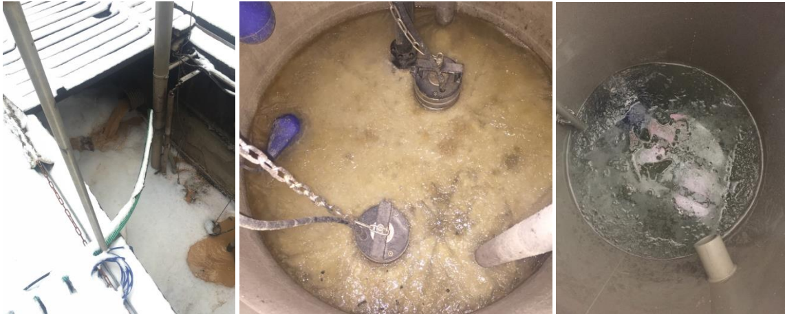
Obr. 21 Zamrzání poloprovzního AnMBR (foto autor)
