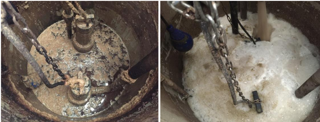
Obr. 24 Poloproduční AnMBR - znečišťování egalizační nádrže a pění obsahu (foto autor)
