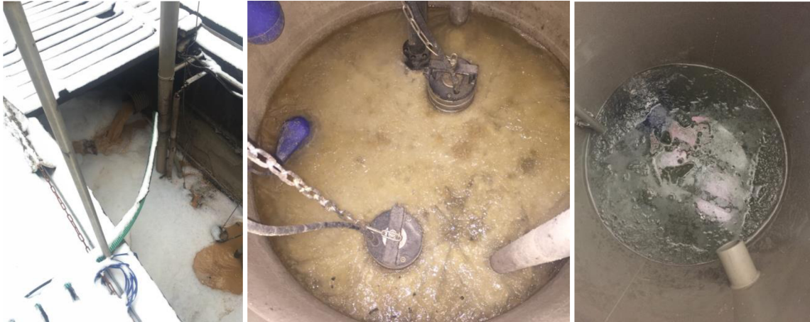
Obr. 21 Zamrzání poloprovozního AnMBR (foto autor)
