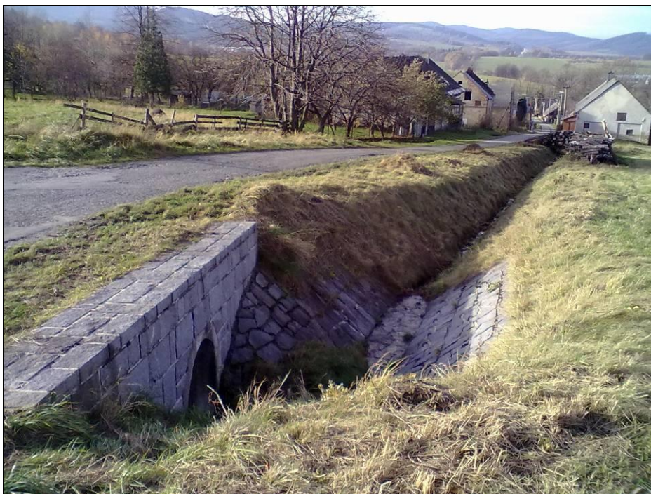
Obr. č. 24: Záchytný příkop ZP1. Autor Pavlína Štanglová.
