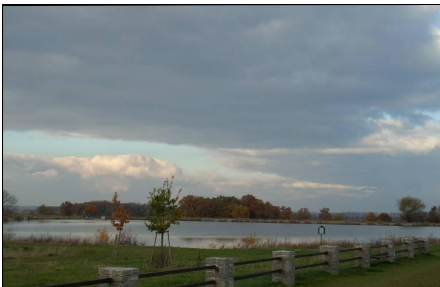
Obr. č. 4: Multifunkční nádrž VOI v k. ú. Javorník Ves. Autor Pavlína Štanglová.
