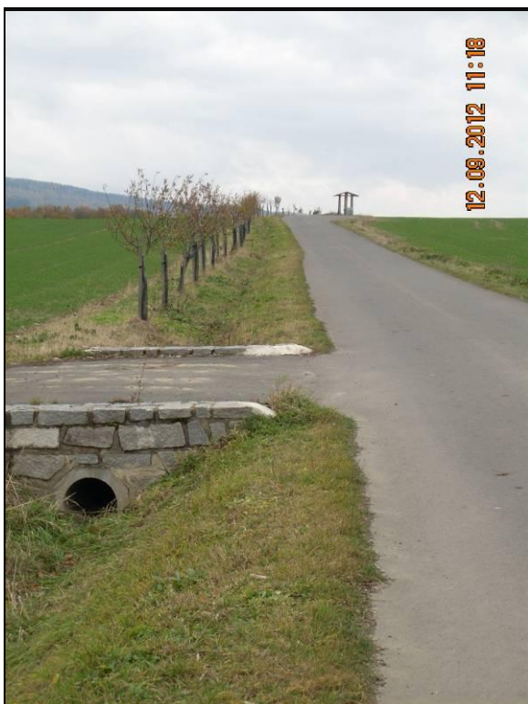
Obr. č. 7: Cesta HC1 se svodným příkopem v k. ú. Dolní Skorošice. Autor Pavlína Štanglová.
