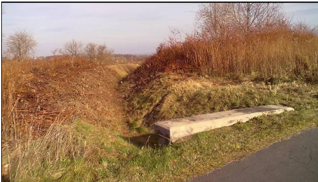
Obr. č. 16: Protierozní záchytný příkop ZP1 v k. ú. Zlaté Hory. Autor Pavlína Štanglov
