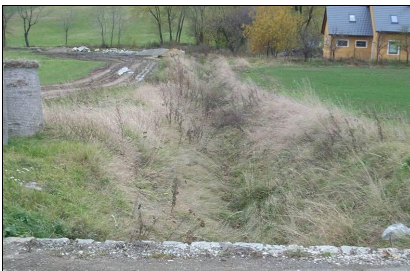
Obr. č. 11: Záchytný příkop U kostela v k. ú. Dolní Skorošice. Autor Pavlína Štanglová.
