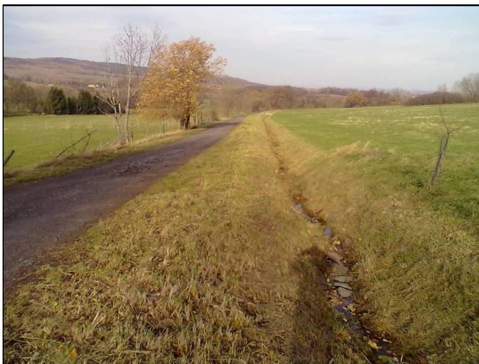
Obr. č. 25: Záchytný příkop ZP2. Autor Pavlína Štanglová.
