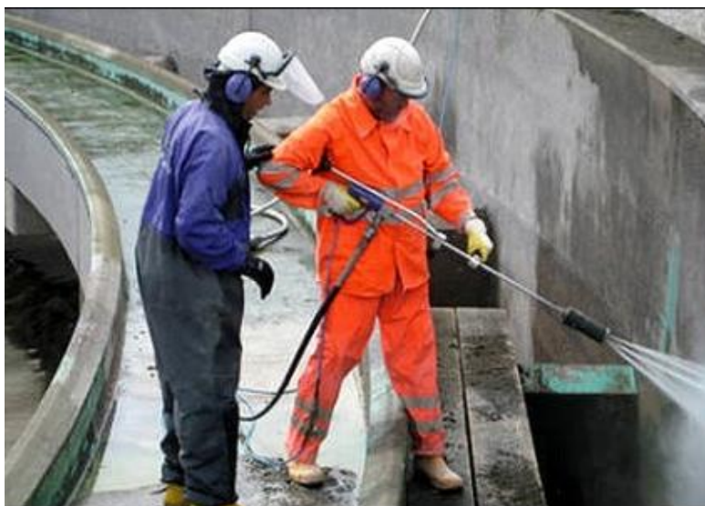
Obrázek 3: Čištění pomocí vysokotlakého paprsku [30]
