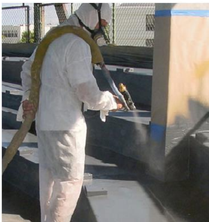
Obrázek 4: Ukázka pneumatického stříkání polymerního nátěru [25]
