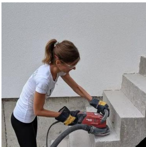
Obrázek 16: Broušení betonového povrchu pomocí ruční brusky [54]
