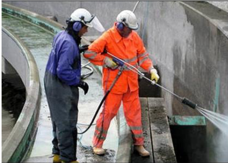
Obrázek 3: Čištění pomocí vysokotlakého paprsku [30]
