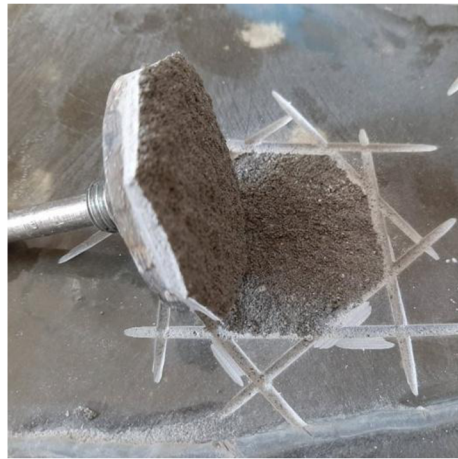
Obrázek 37: Porušení nátěru EP-W PL v povrchové vrstvě betonové dlažby (2 mm)
