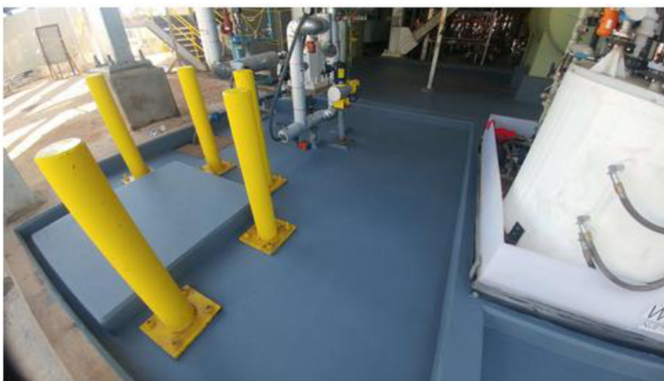
Obrázek 1: Sekundární ochrana betonové konstrukce proti účinkům agresivních chemikáliím [24]
