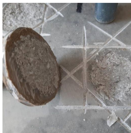
Obrázek 36: Odtrhový terč po porušení nátěru EP-S PL nátěr/beton
