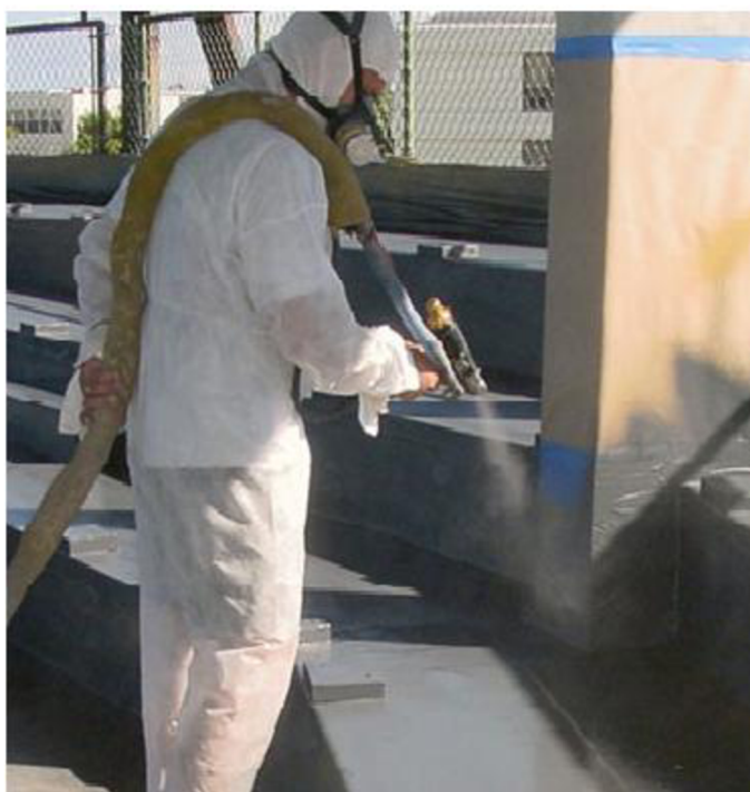
Obrázek 4: Ukázka pneumatického stříkání polymerního nátěru [25]
