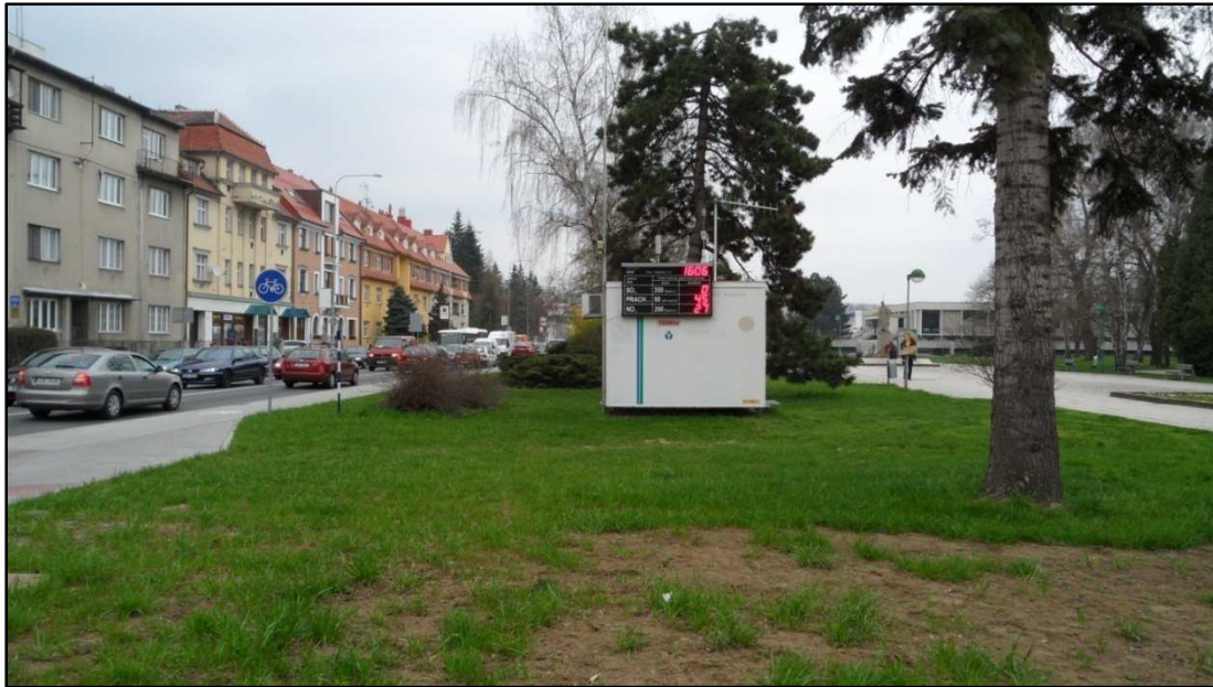
Obr. 2.1 AMS na náměstí Míru v Uherském Hradišti. (foto B. Otrusina)
