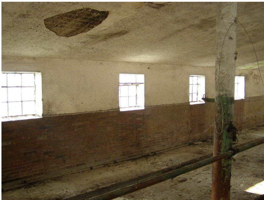
Foto č.4: Pohled na vnitřní povrch stěn („Foto Petr Horký)
