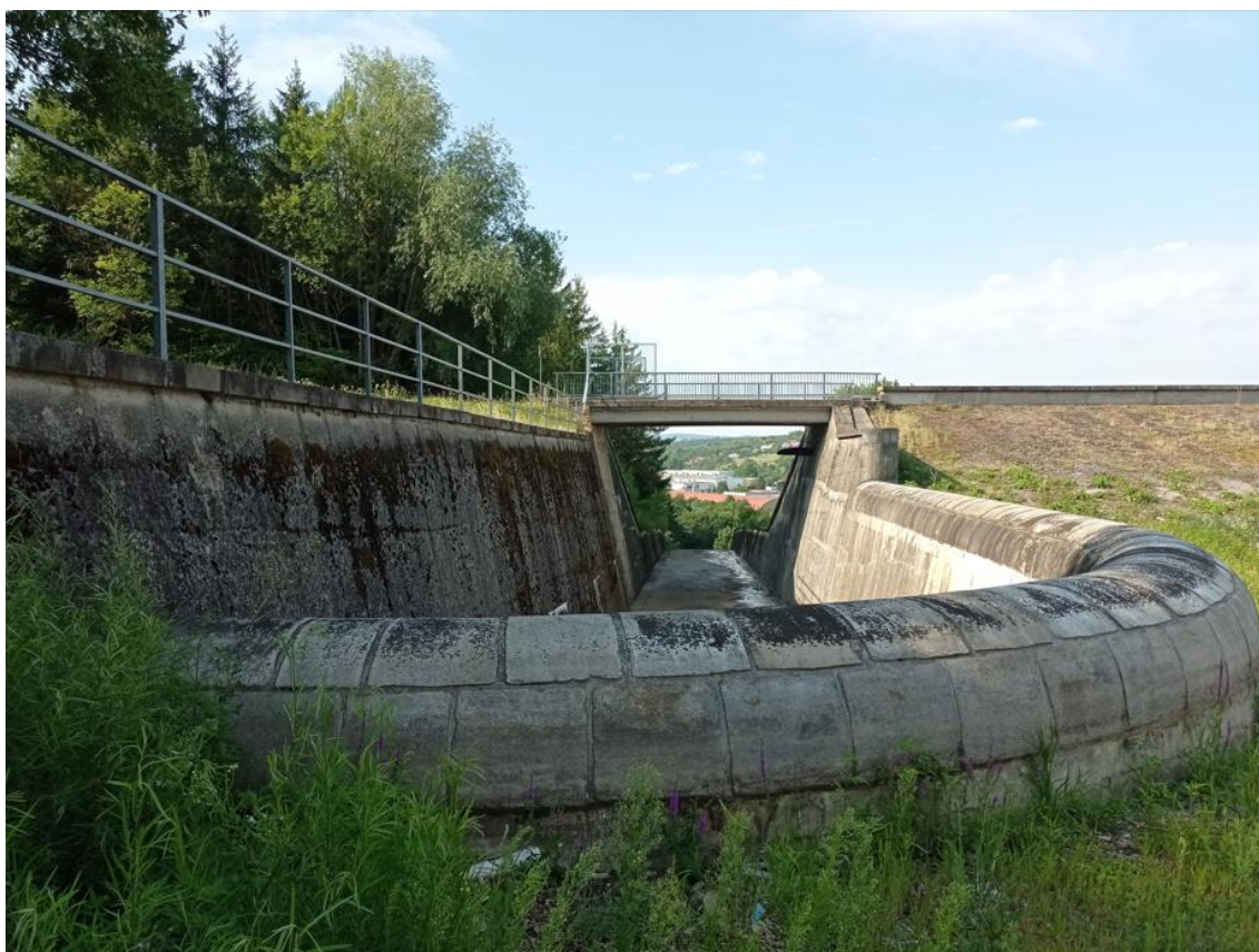
Obr. 15 bezp. přeliv, pohled ve směru proudění [30]
