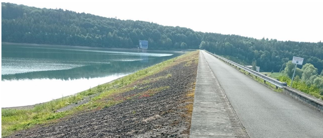
Obr. 11: Koruna a návodní líc hráze [30]
