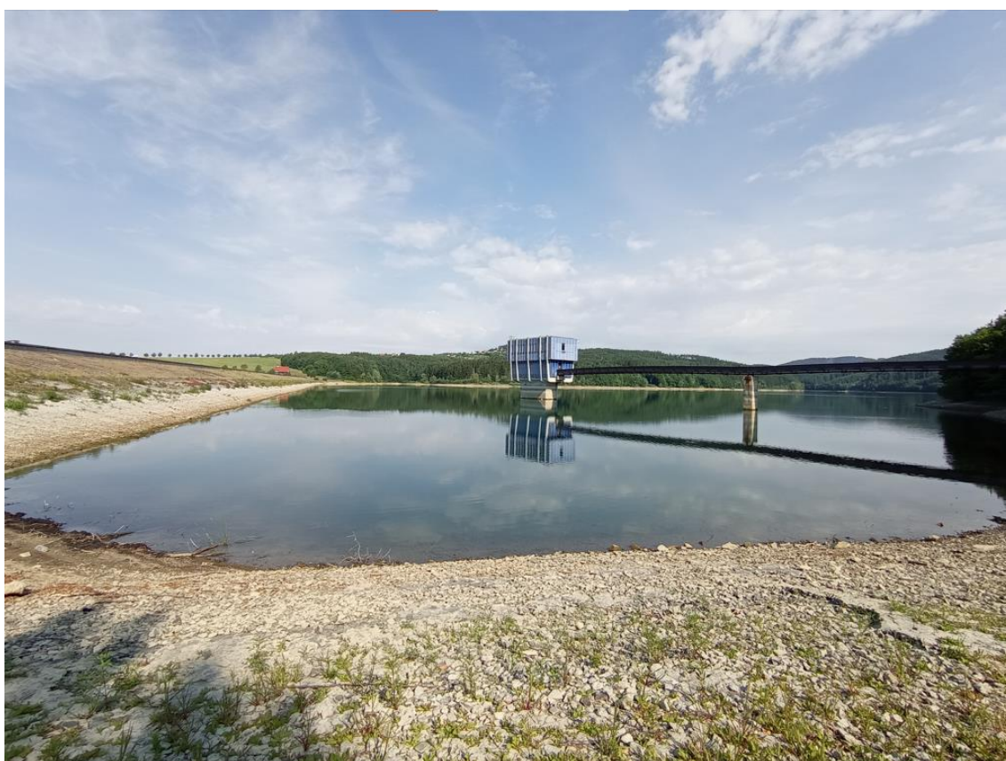
Obr. 18 pohled na nádrž a vtokový objekt [30]
