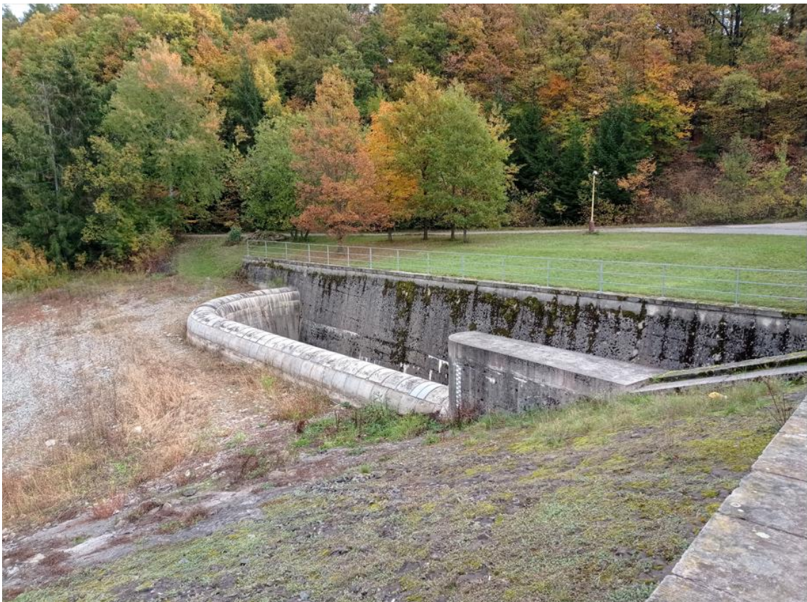
Obr. 13 bezpečnostní přeliv, předpolí přelivu [30]
