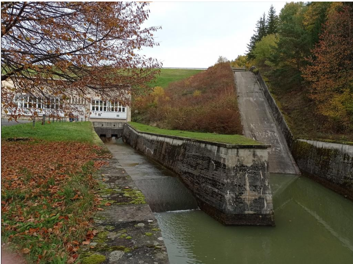
Obr. 20 odtok z výpustného objektu (vlevo), skluz (vpravo) [30]
