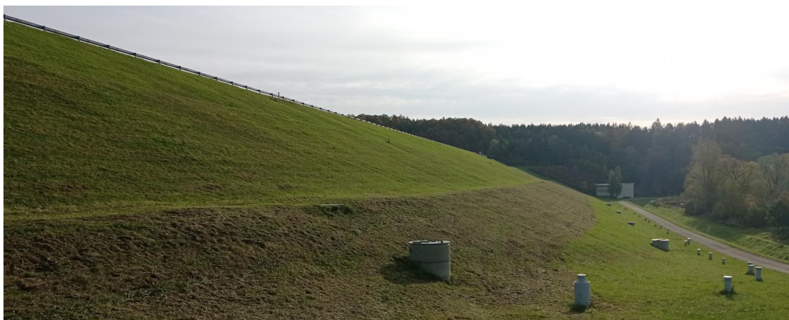
Obr. 12 Vzdušná líc hráze [30]
