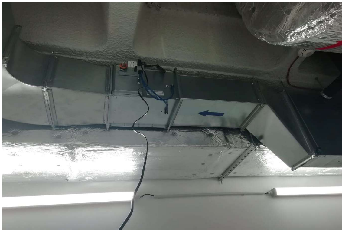
Obr. 14.3 Měřená trasa VZT potrubí
