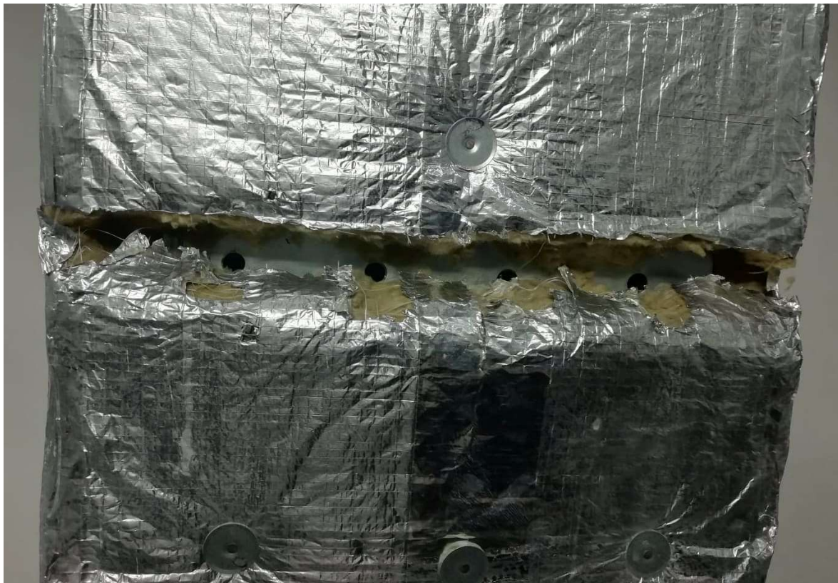
Obr. 14.4 Měřicí otvory vyvrtané do odvodního potrubí
