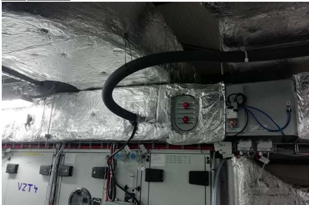
Obr. 13.4 Měřená trasa VZT potrubí
