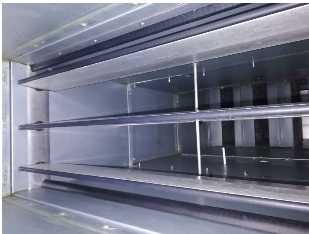
Obr. 13.5 Otevřené listy regulátoru, tlumič hluku osazený před regulátorem
