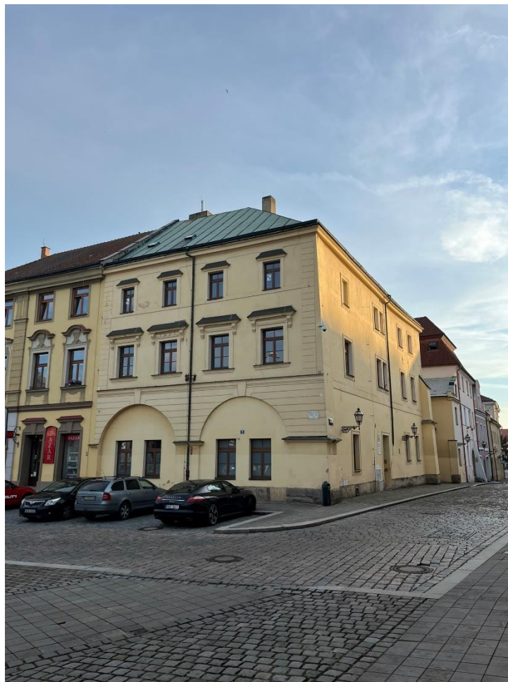
Obr. č. 77 Dům čp. 127 v roce 2024 (foto P. Bártík)
