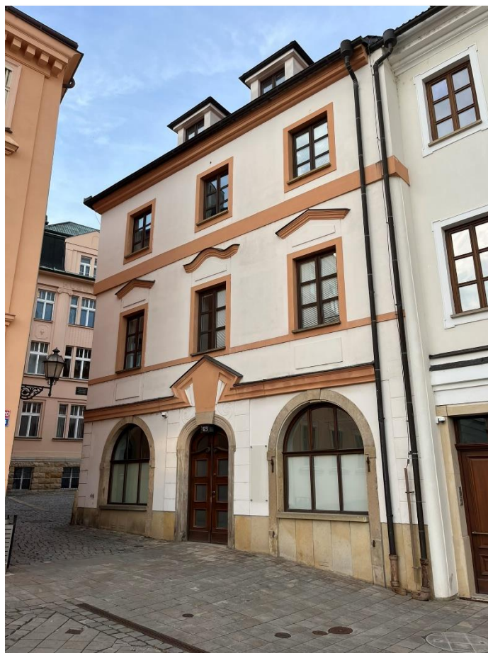
Obr. č. 70 Dům čp. 123 v roce 2024 (foto P. Bártík)
