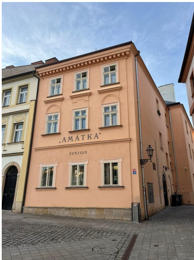
Obr. č. 60 Dům čp. 120 v roce 2024 (foto P. Bártík)
