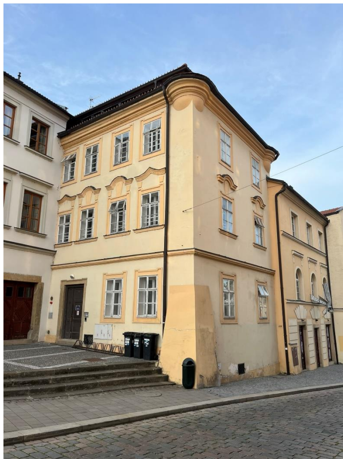
Obr. č. 74 Dům čp. 126 v roce 2024 (foto P. Bártík)
