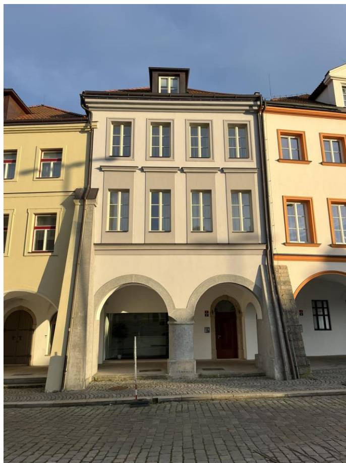
Obr. č. 33 Dům čp. 5 v roce 2024 (foto P. Bártík)
