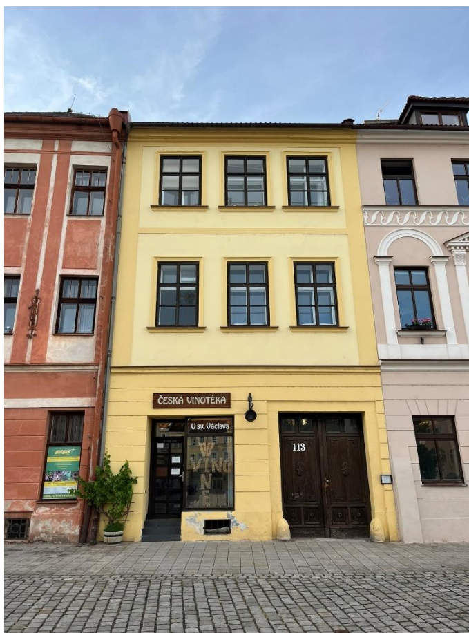
Obr. č. 53 Dům čp. 113 v roce 2024 (foto P. Bártík)
