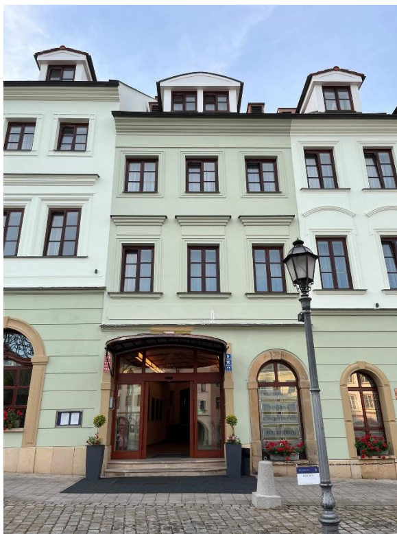
Obr. č. 57 Dům čp. 117 v roce 2024 (foto P. Bártík)
