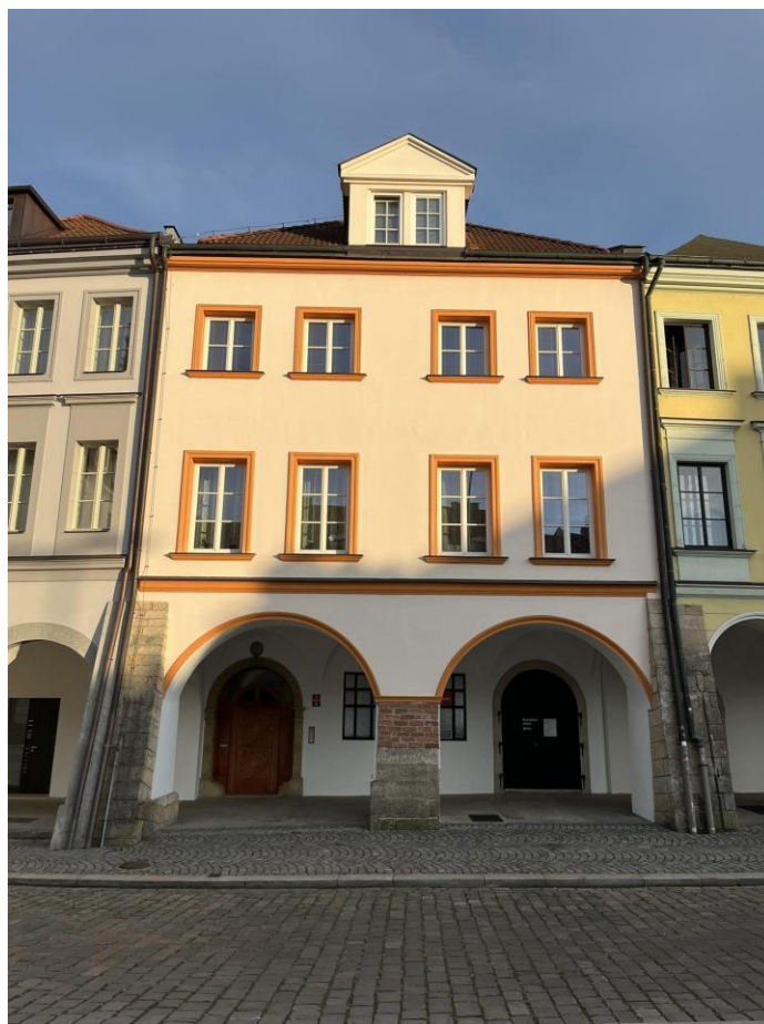
Obr. č. 36 Dům čp. 6 v roce 2024 (foto P. Bártík)
