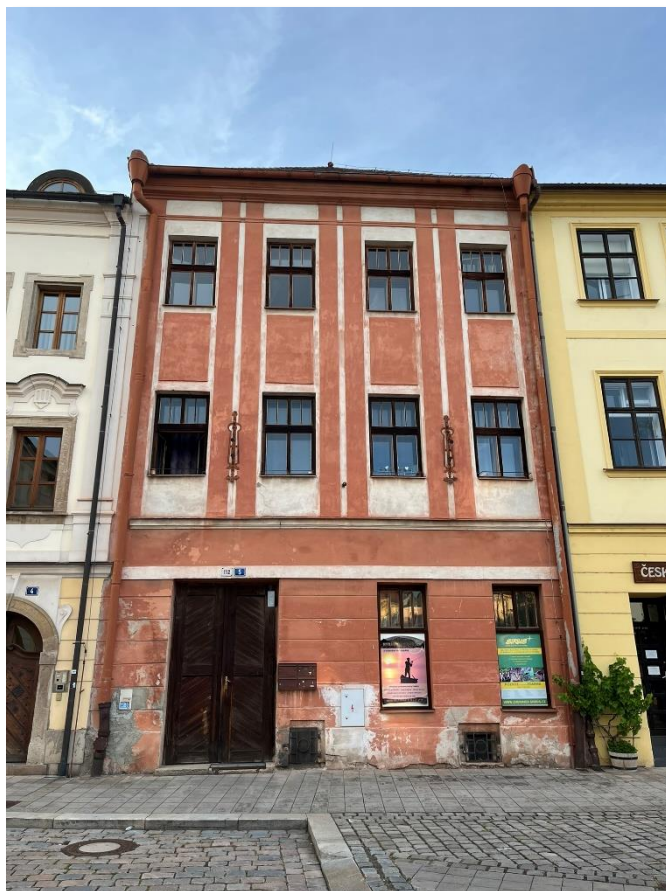
Obr. č. 52 Dům čp. 112 v roce 2024 (foto P. Bártík)
