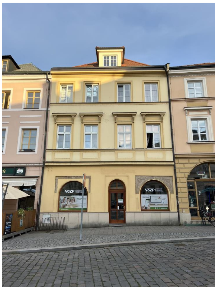
Obr. č. 45 Dům čp. 13 v roce 2024 (foto P. Bártík)
