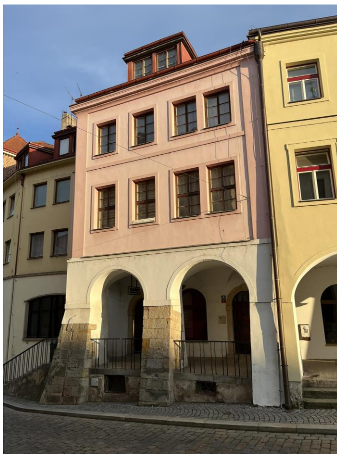
Obr. č. 28 Dům čp. 3 v roce 2024 (foto P. Bártík)
