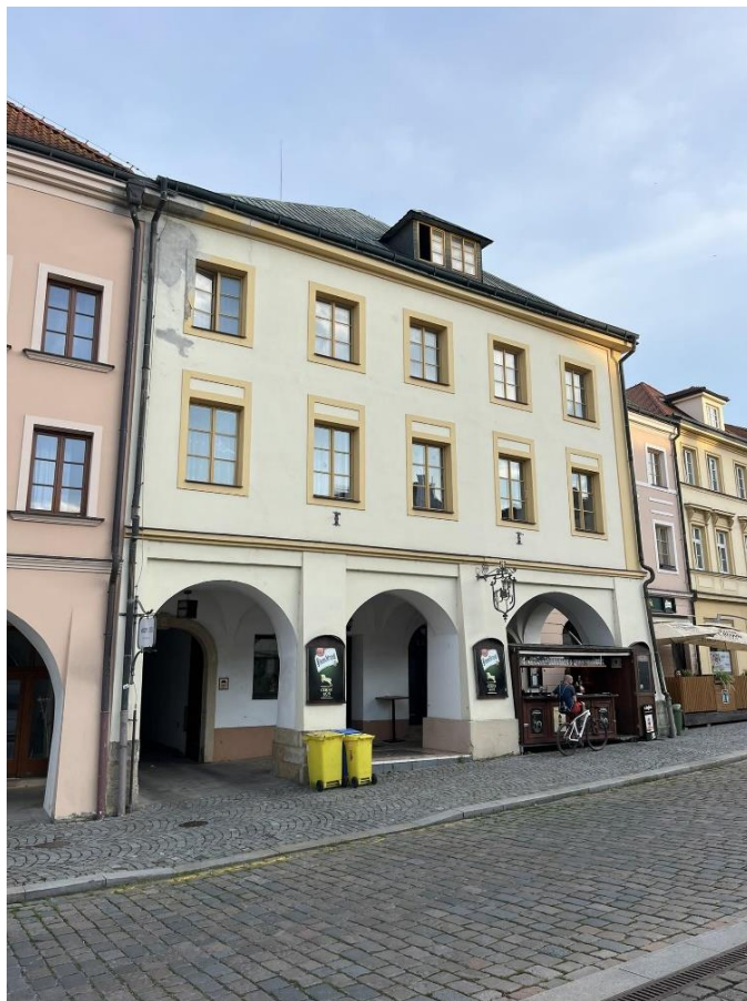
Obr. č. 41 Dům čp. 10 v roce 2024 (foto P. Bártík)
