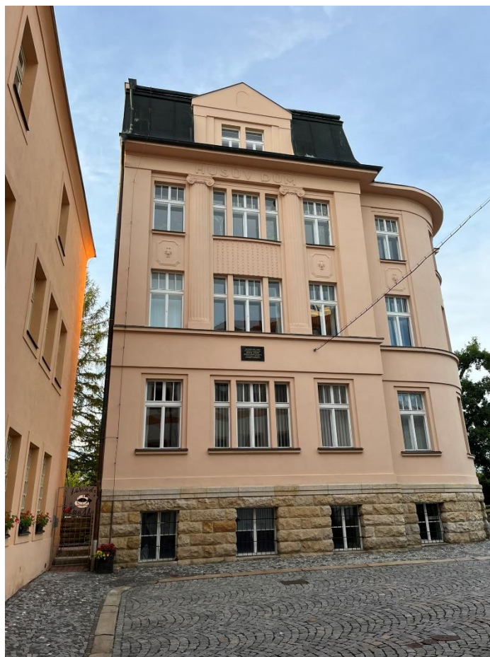
Obr. č. 64 Dům čp. 121 v roce 2024 (foto P. Bártík)
