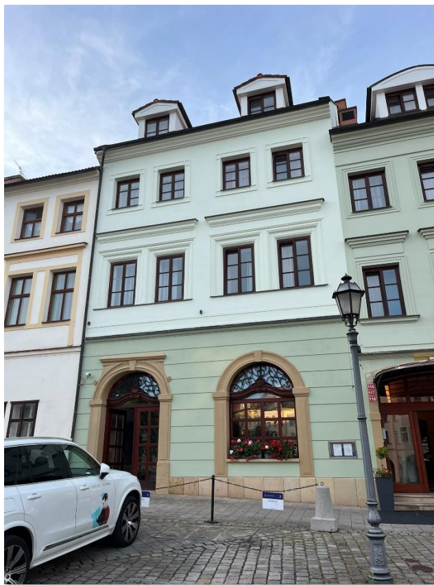
Obr. č. 56 Dům čp. 116 v roce 2024 (foto P. Bártík)
