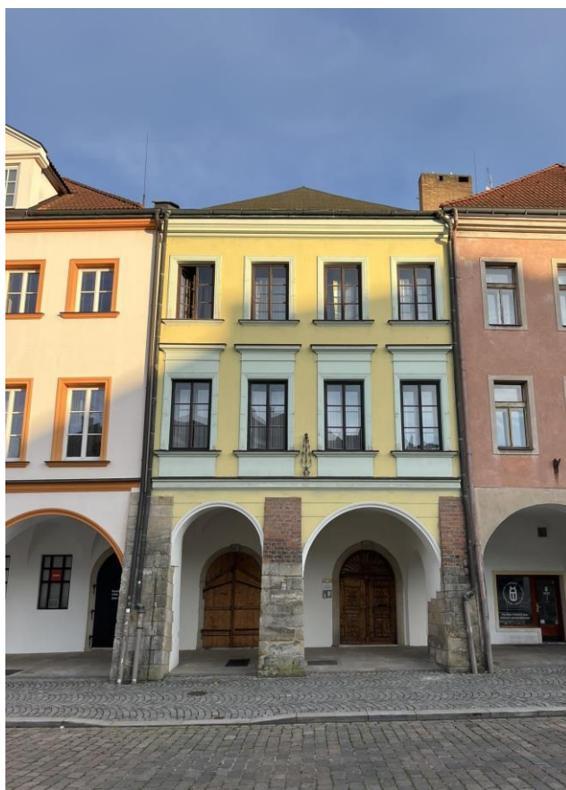
Obr. č. 37 Dům čp. 7 v roce 2024 (foto P. Bártík)
