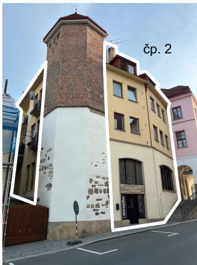
Obr. č. 23 Dům čp. 2 s pozůstatkem Slezské (Mýtské) brány v roce 2024 (foto P. Bártík)
