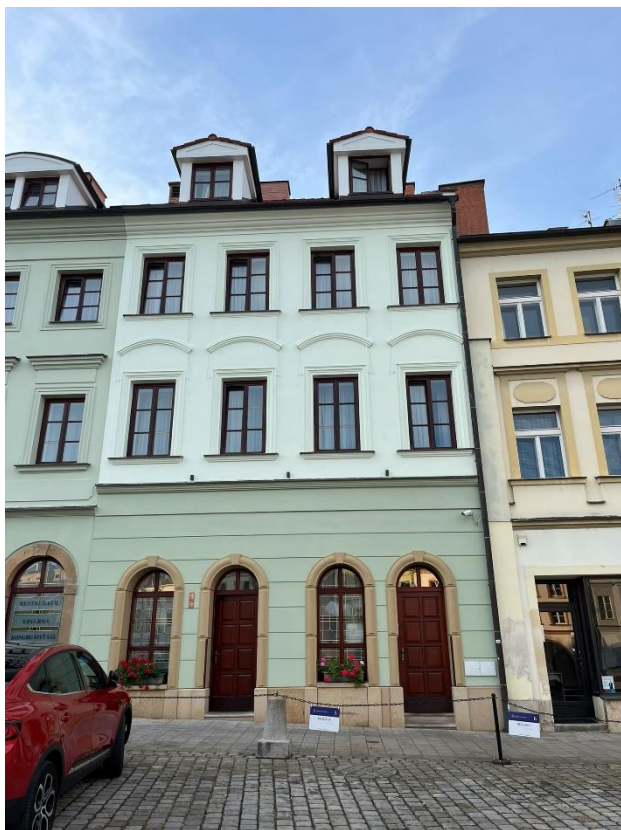
Obr. č. 58 Dům čp. 118 v roce 2024 (foto P. Bártík)
