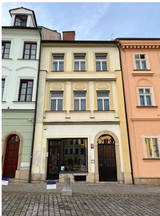
Obr. č. 59 Dům čp. 119 v roce 2024 (foto P. Bártík)
