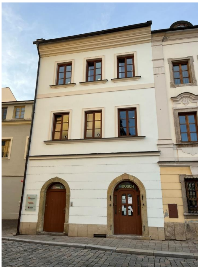
Obr. č. 50 Dům čp. 110 v roce 2024 (foto P. Bártík)
