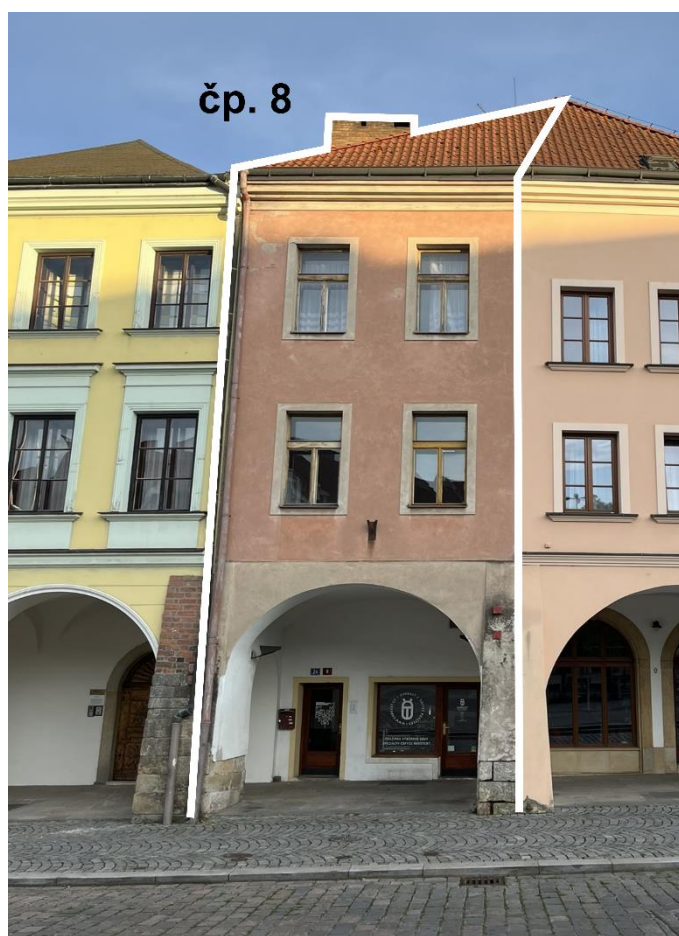
Obr. č. 38 Dům čp. 8 v roce 2024 (foto P. Bártík)
