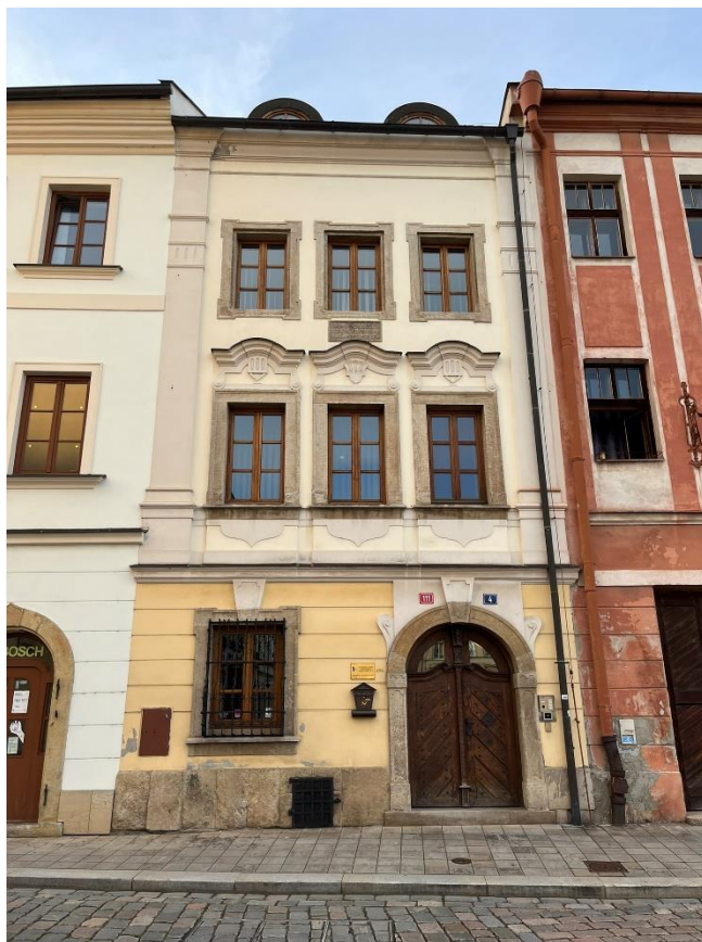
Obr. č. 51 Dům čp. 111 v roce 2024 (foto P. Bártík)
