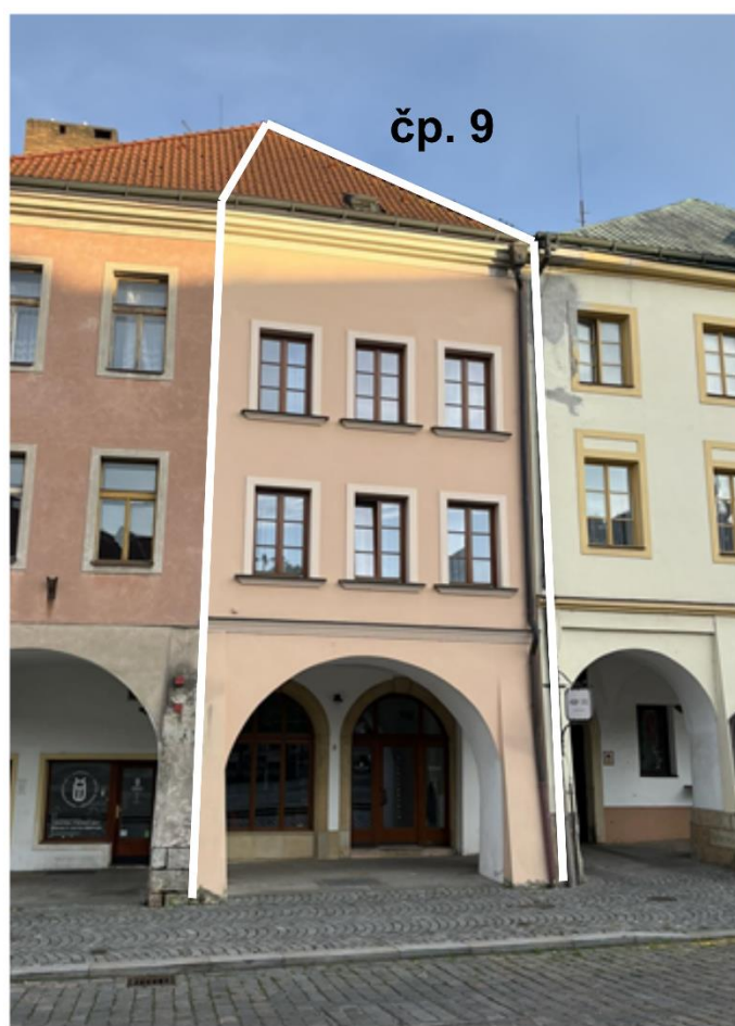
Obr. č. 40 Dům čp. 9 v roce 2024 (foto P. Bártík)
