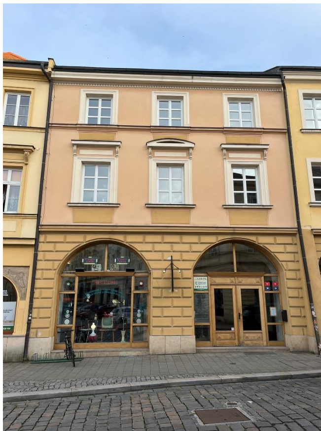
Obr. č. 46 Dům čp. 14 v roce 2024 (foto P. Bártík)
