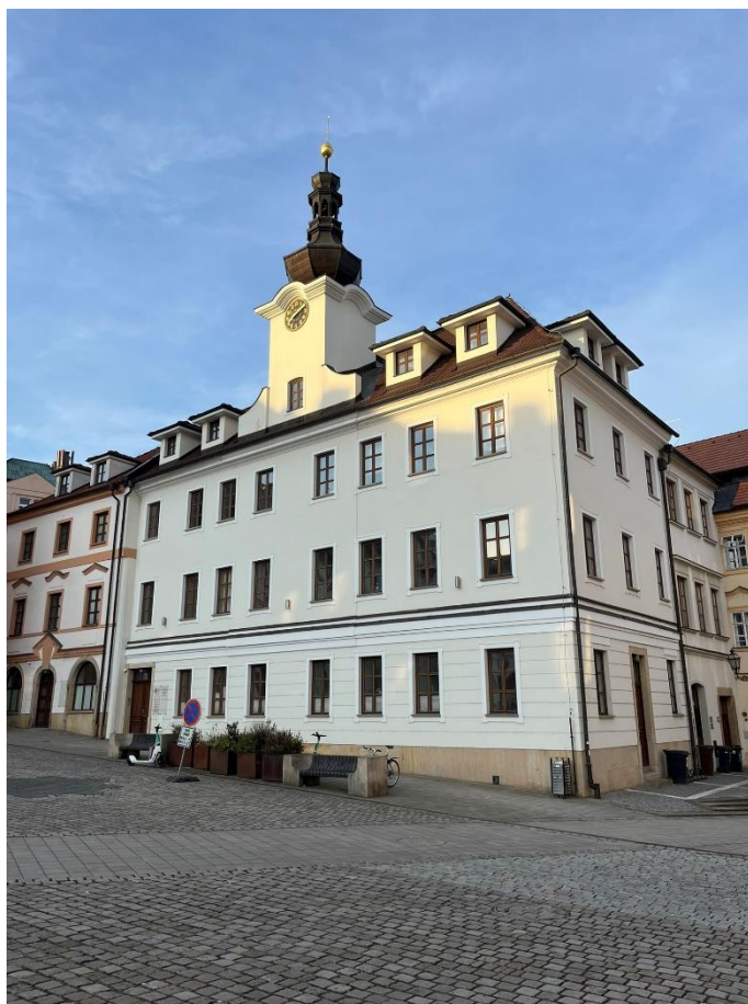
Obr. č. 71 Dům čp. 124 v roce 2024 (foto P. Bártík)
