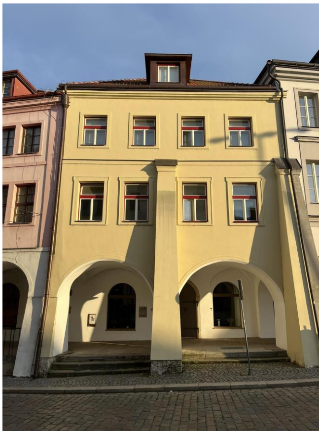
Obr. č. 30 Dům čp. 4 v roce 2024 (foto P. Bártík)
