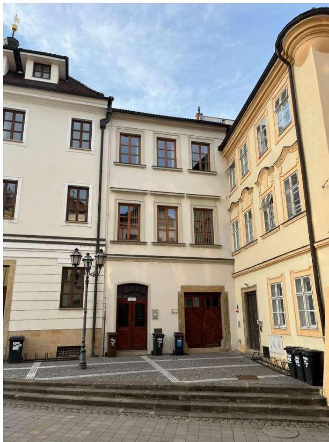
Obr. č. 73 Dům čp. 125 v roce 2024 (foto P. Bártík)
