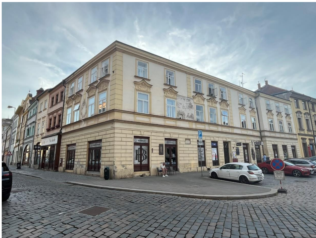
Obr. č. 83 Dům čp. 129 v roce 2024 (foto P. Bártík)
