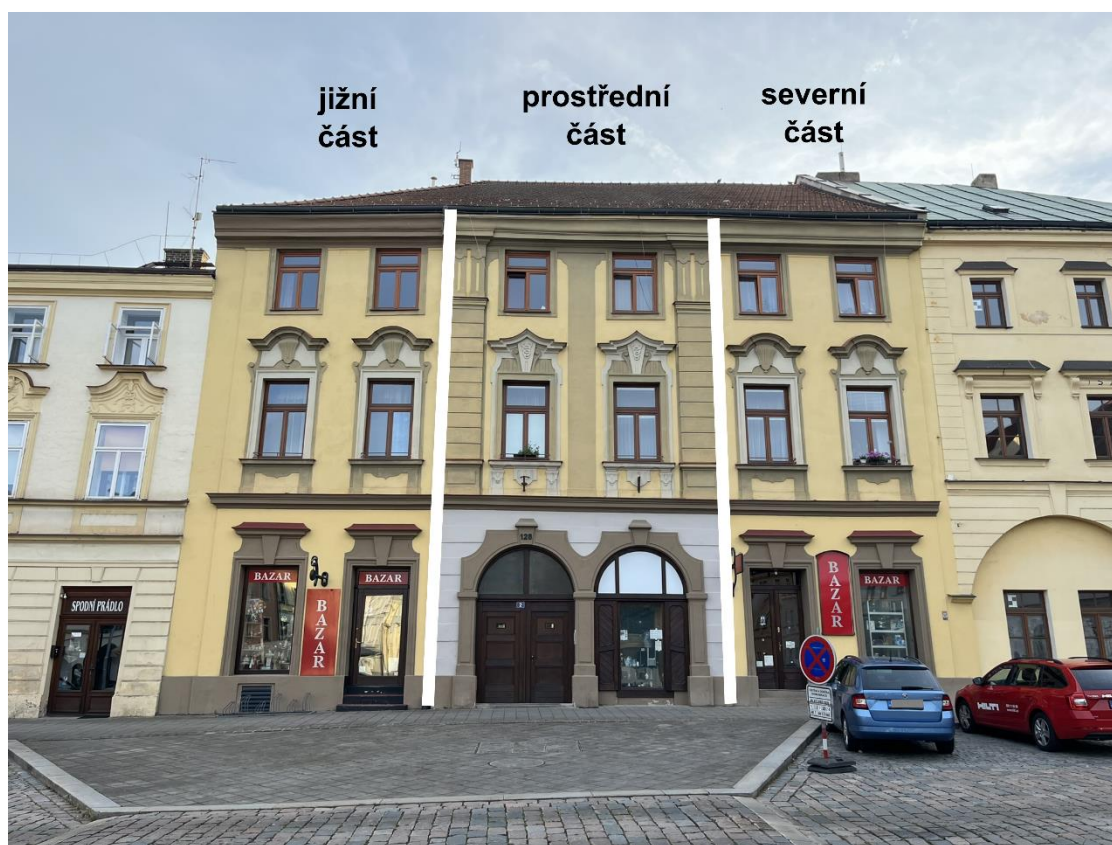
Obr. č. 81 Dům čp. 128 v roce 2024 (foto P. Bártík)
