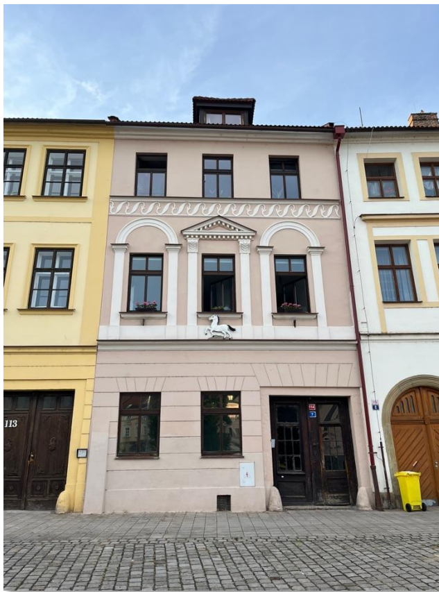
Obr. č. 54 Dům čp. 114 v roce 2024 (foto P. Bártík)
