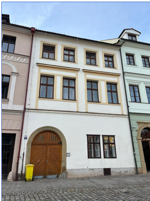
Obr. č. 55 Dům čp. 115 v roce 2024 (foto P. Bártík)
