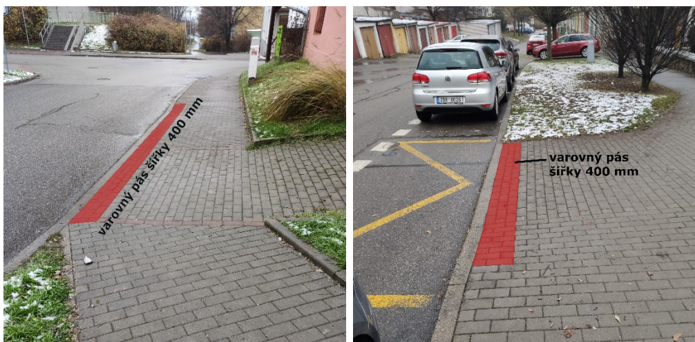
Obr. 128 Návrh úprav sjezdů
