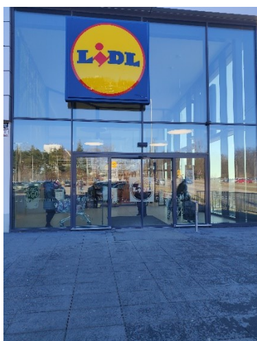
Obr. 170 Vstup do obchodního domu Lidl
