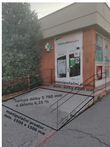
Obr. 62 Návrh přístupové rampy k lékárně
