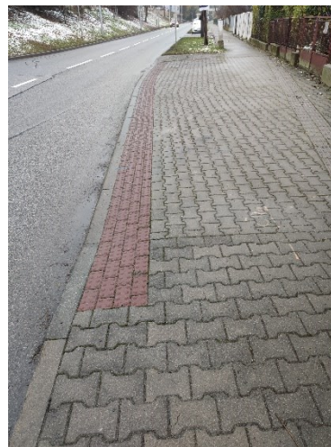
Obr. 100 Varovný pás v místě sjezdu
