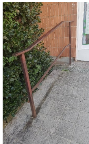
Obr. 63 Zábradlí u rampy před lékárnou
