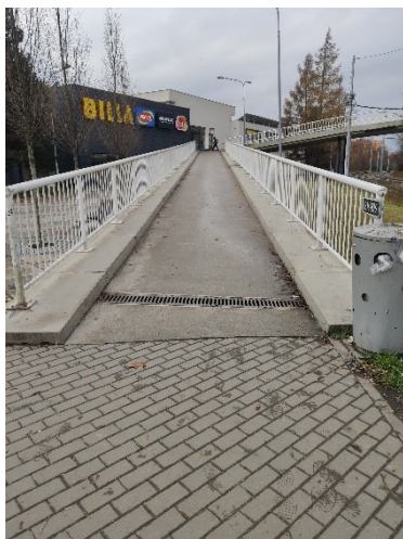
Obr. 151 Přístupová rampa do OC Kavkaz
