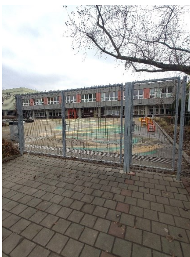
Obr. 164 Vstup do areálu základní a mateřské školy Vedlejší 10
