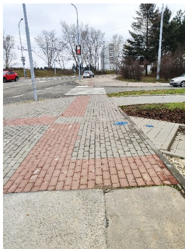
Obr. 172 Nevhodné napojení signálního pásu na zahradní obrubník
