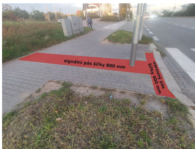
Obr. 209 Návrh úpravy přechodu v ulici Jihlavská (pohled 2)
