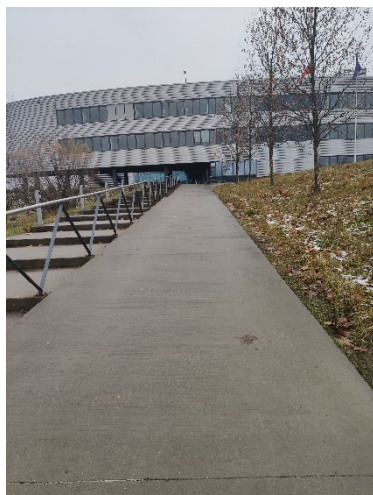
Obr. 246 Přístupová rampa fakulty sportovních studií
