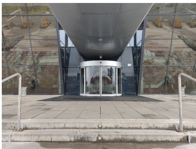
Obr. 234 Vstup do budovy lékařské fakulty
