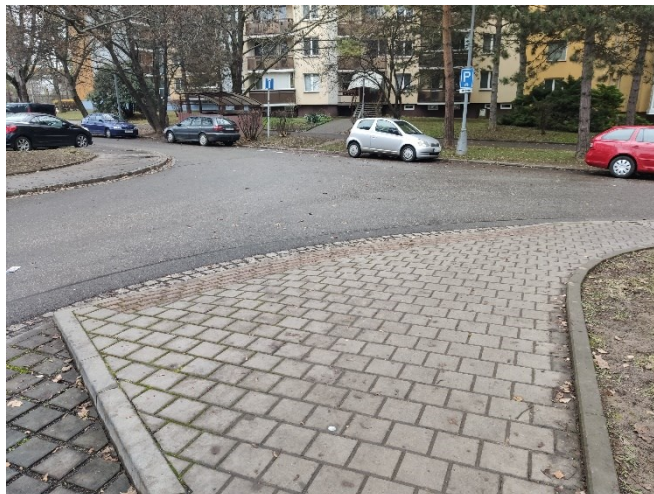
Obr. 177 Chybějící návaznost chodníků v ulicích Pod nemocnicí a Uzbecká
