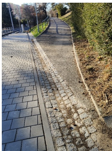
Obr. 190 Ukončení rampy rigolem u nástupiště Běloruská (směr Starý Lískovec)
