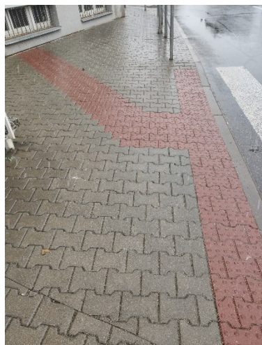
Obr. 101 Původní signální pás
