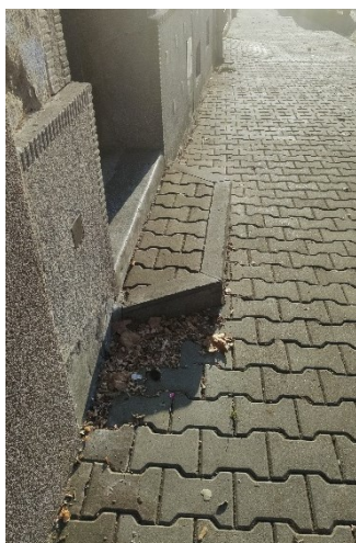
Obr. 122 Předsazené stupně zasahující do prostoru chodníku
