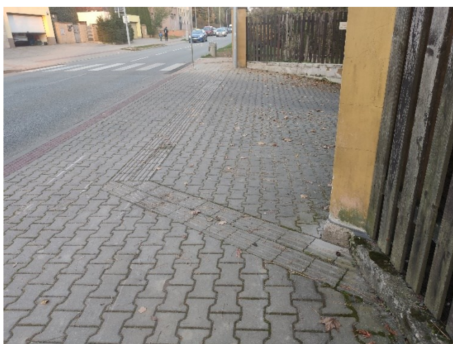
Obr. 106 Navazující signalizační pás na přirozenou vodící linii
