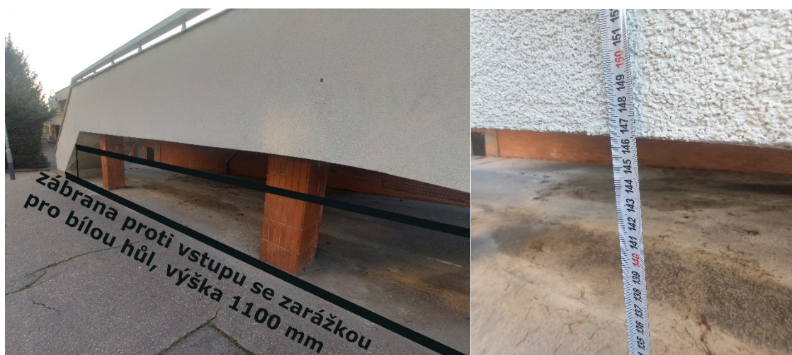
Obr. 64 Prostor pod konstrukcí schodiště a rampy
