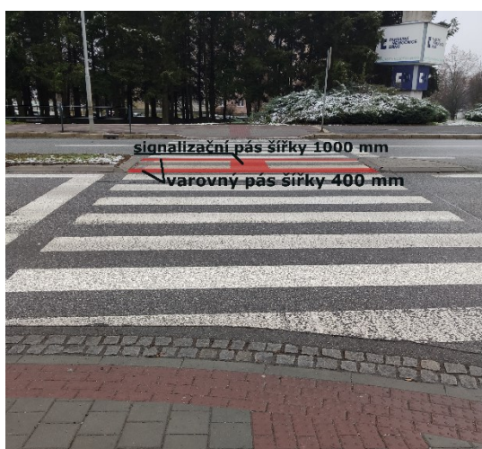
Obr. 264 Návrh úpravy ostrůvku s vyčkávacím prostorem
