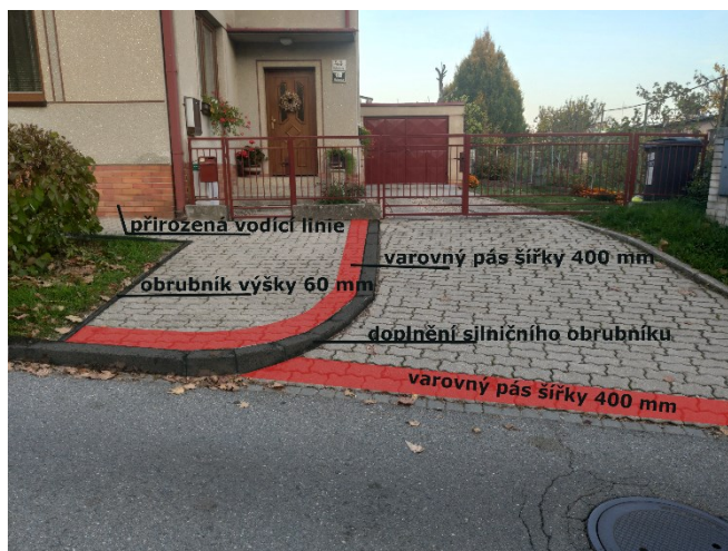
Obr. 94 Návrh úpravy ukončení chodníku
