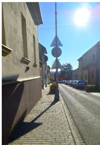
Obr. 91 Stožár veřejného osvětlení omezující průchozí šířku
