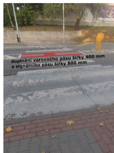
Obr. 216 Návrh úpravy přechodu přes ulici Kamenice)
