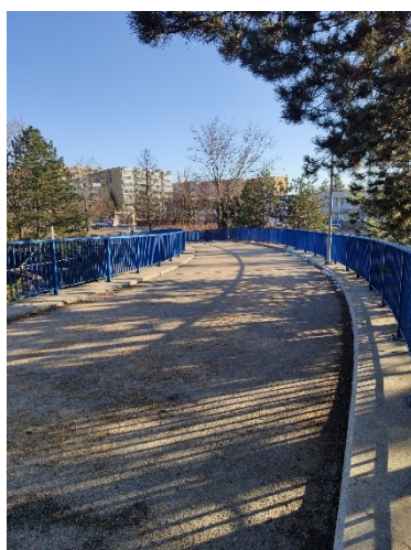
Obr. 187 Most přes tramvajovou trať na ulici Uzbeká
