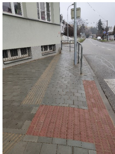
Obr. 102 Úprava hmatového značení
