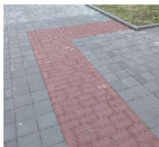
Obr. 11 Signální pás napojený na obrubník výšky 60 mm
