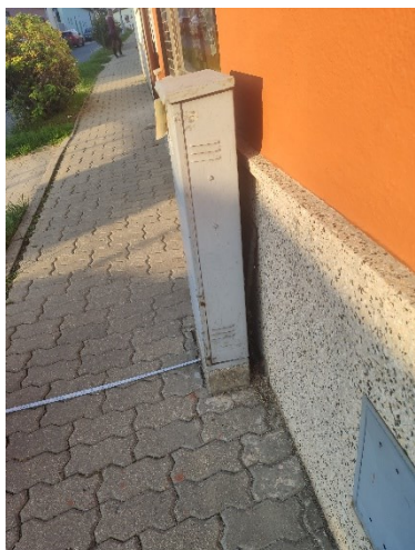
Obr. 92 Přípojková skříň zasahující do průchozí šířky chodníku
