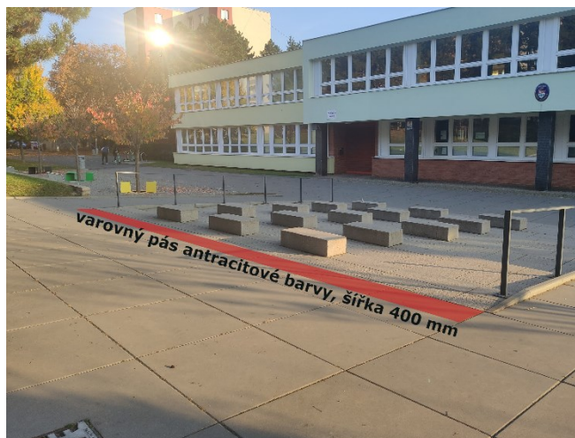
Obr. 72 Návrh úpravy pobytových schodů
