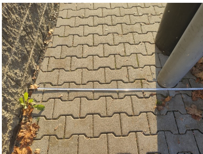
Obr. 120 průchozí šířka u stožáru veřejného osvětlení
