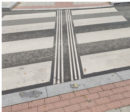
Obr. 13 Vodící pás přechodu
