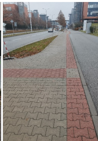
Obr. 257 Napojení signálního pásu přechodu na pás varovný a hmatný
