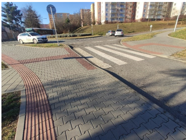
Obr. 133 Hmatové a kontrastní prvky chodníku u kruhového objezdu
