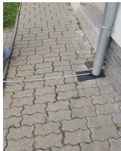
Obr. 89 Svod vody omezující průchozí šířku
