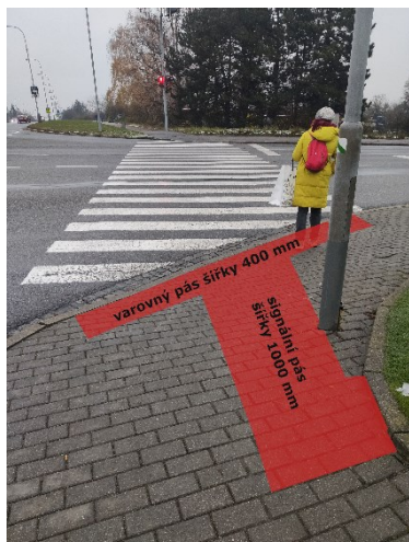
Obr. 210 Návrh úpravy přechodu v ulici Dlouhá
