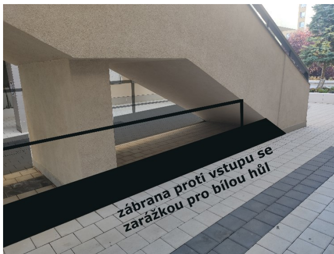
Obr. 48 Návrh úpravy schodišťového prostoru
