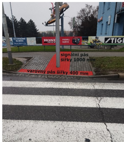
Obr. 211 Návrh úpravy přechodu v ulici Jihlavská (pohled 1)
