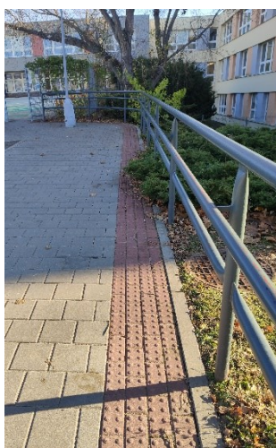
Obr. 163 Nahrazení přirozené vodící linie varovným pásem
