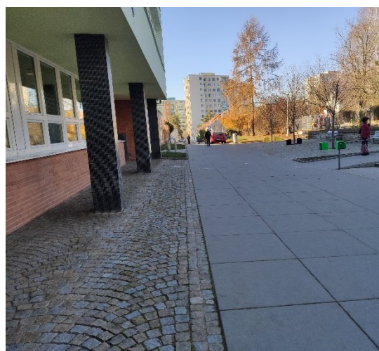
Obr. 73 Povrchová úprava před vstupem do areálu školy
