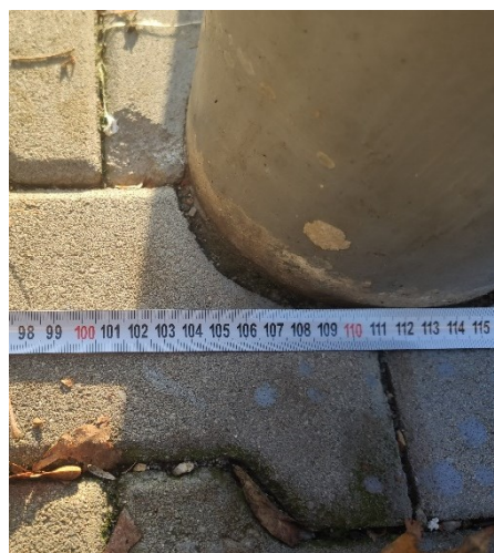
Obr. 120 průchozí šířka u stožáru veřejného osvětlení
