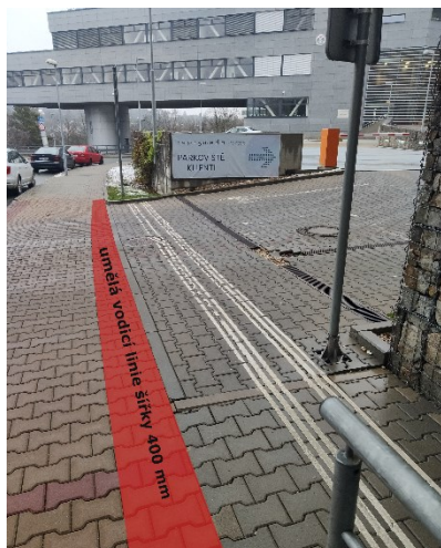
Obr. 255 Návrh úpravy nevhodně zvolené umělé vodicí linie
