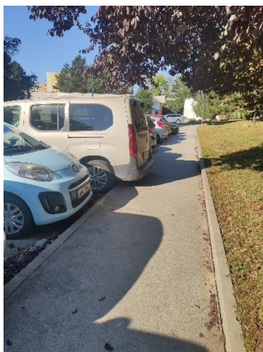
Obr. 55 Auta zasahující do průchozího prostoru chodníku
