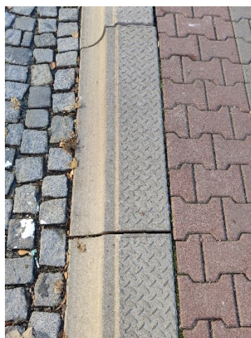
Obr. 34 Bezbariérový zastávkový obrubník
