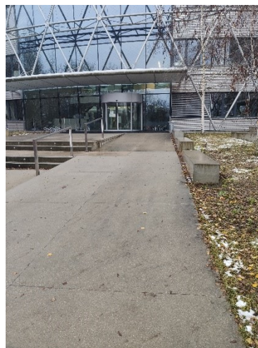
Obr. 251 Přístupová rampa k výzkumnému centru
