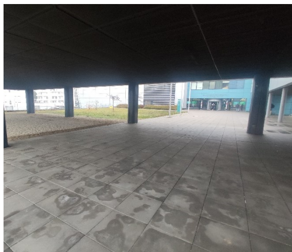
Obr. 242 Rozlehlý prostor před budovou fakulty sportovních studií
