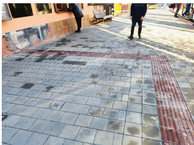
Obr. 192 Umělá vodicí linie navazující na stánek
