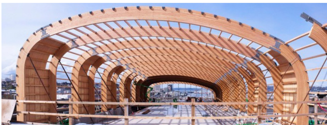
Obrázek 25 Příklad obloukové konstrukce z lepeného dřeva
