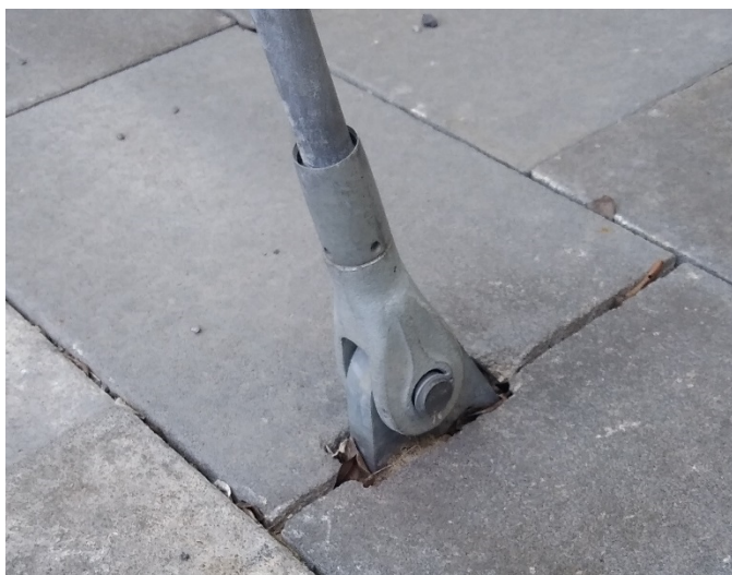
Obrázek 48 Přikotvení táhla do země
