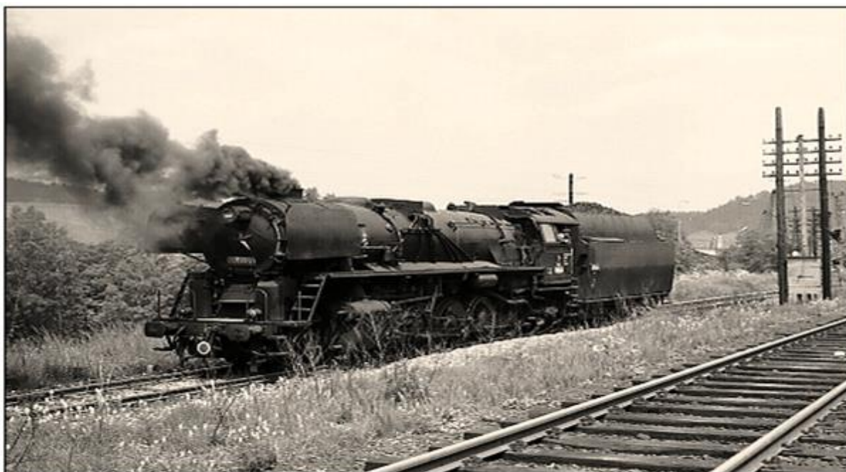
Obrázek č. 17: dobová fotografie železnice
