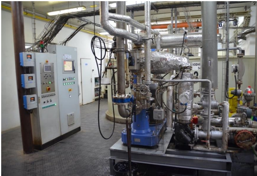
Obrázek 5: Koloidní mlýn, zdroj: (13)
