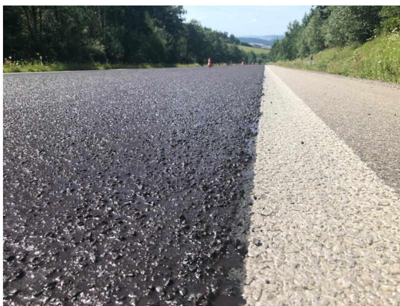
Obrázek 2: Čerstvě položený mikrokoberec 0/5, začátek štěpení, zdroj: (13)
