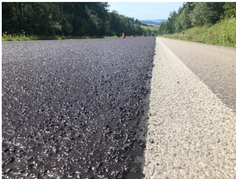
Obrázek 2: Čerstvě položený mikrokoberec 0/5, začátek štěpení, zdroj: (13)
