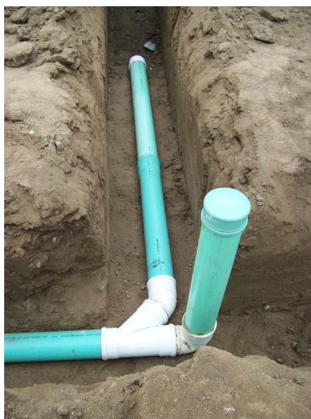
Obr.17 – Sestavená šachtička (zdroj: Kanapipeline)
