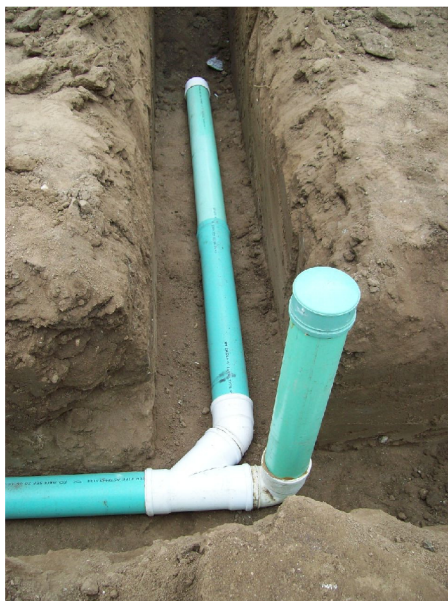
Obr.17 – Sestavená šachtička (zdroj: Kanapipeline)
