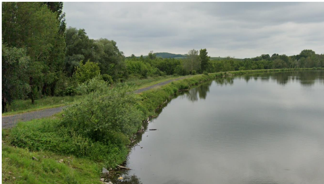
Obr. 12 Boční hráz horní části horní nádrže [23]
