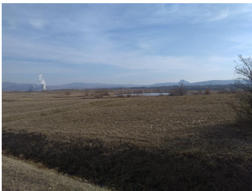
Obrázek 36: Jezero Ema, v dálce elektrárna Ledvice (fotografie č. 4)
