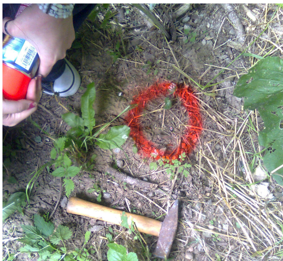
Obrázek 7: Pomocný měřický bod stabilizovaný roxorem
