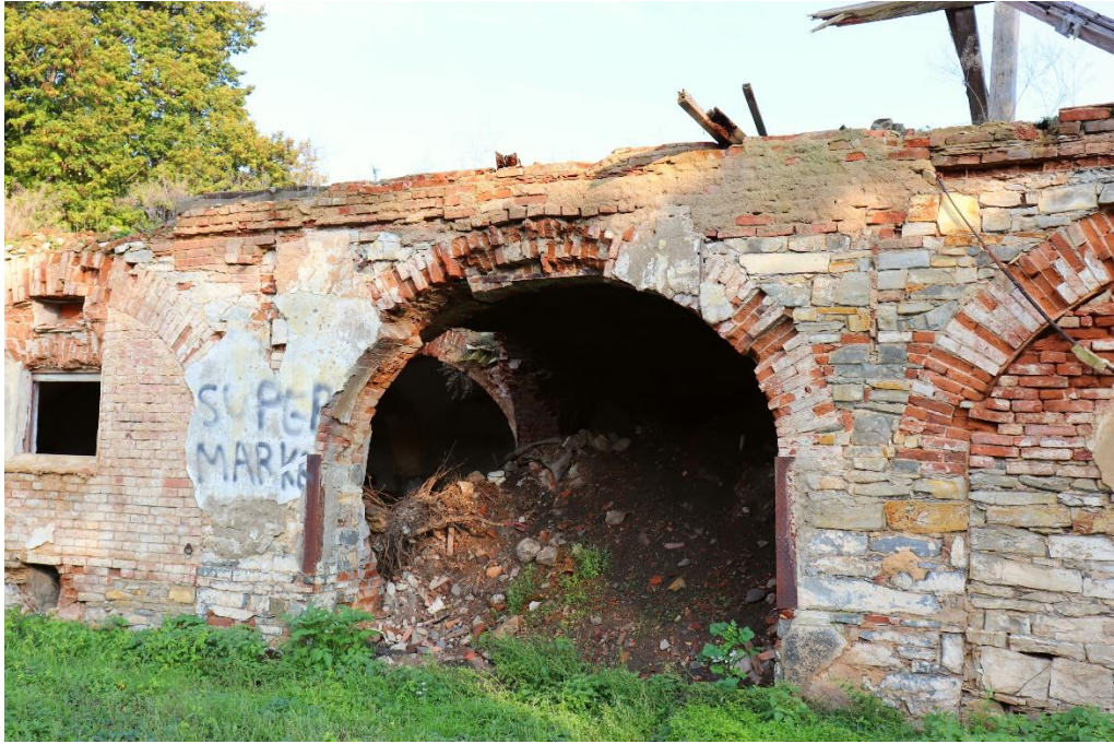
Obr. 35: Budova bývalého kravína v Ploskovicích (Šrámek, 2021)
