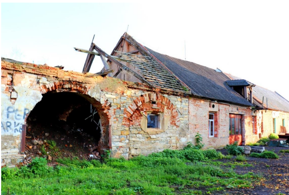
Obr. 34: Budova bývalého kravína v Ploskovicích (Šrámek, 2021)
