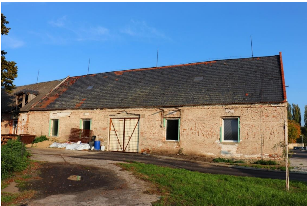
Obr. 33: Budova bývalého kravína v Ploskovicích (Šrámek, 2021)
