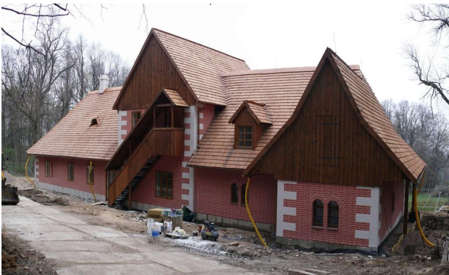
Obrázek 2: Muzeum Švýcárna v průběhu rekonstrukce. Zdroj: respondent č. 1
