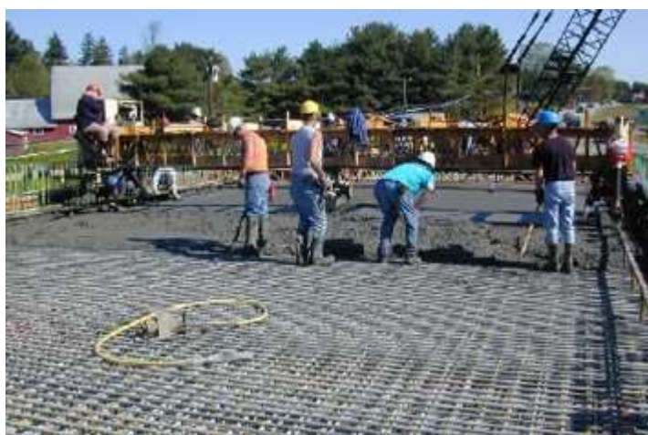
Obrázek 12 Betonová mostní vozovka s GFRP výztuží [62]
