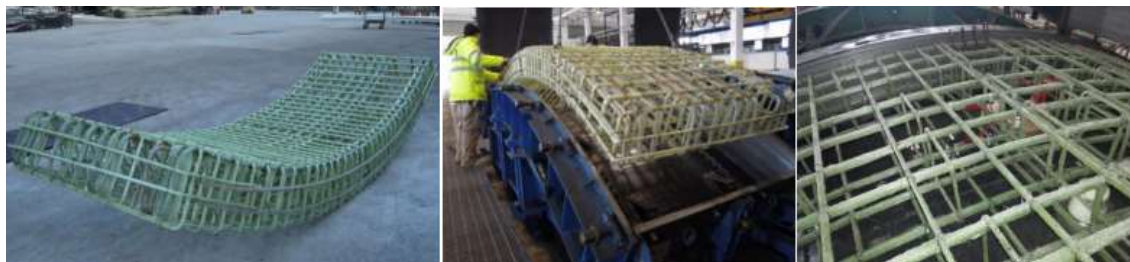
Obrázek 20 GFRP výztuž do prefabrikovaného ostění tunelu [72]
