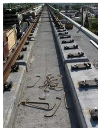
Obrázek 15 Železniční pražce plně vyztužené z GFRP výztuží – Miami železniční trať [73]
