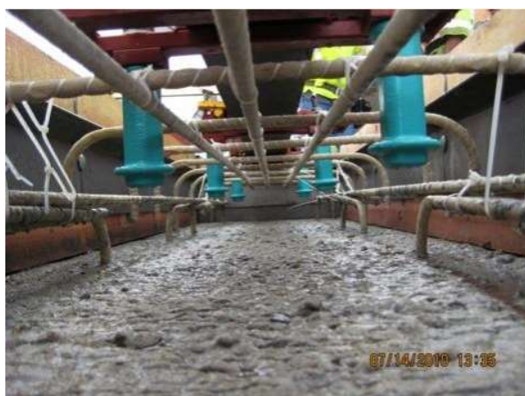
Obrázek 15 Železniční pražce plně vyztužené z GFRP výztuží – Miami železniční trať [73]
