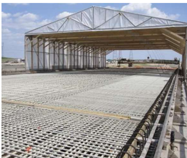
Obrázek 13 Uložení výztuží před zalitím betonem; Most přes Assiniboine River; Brandon, Manitoba, Canada [76]
