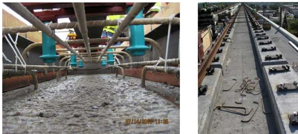
Obrázek 15 Železniční pražce plně vyztužené z GFRP výztuží – Miami železniční trať [73]
