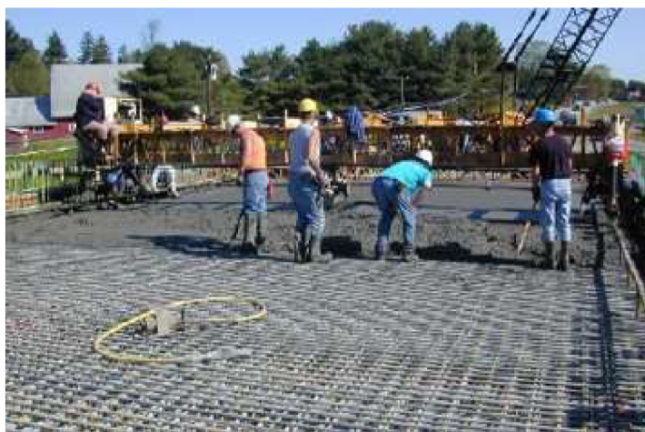
Obrázek 12 Betonová mostní vozovka s GFRP výztuží [62]
