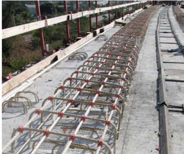
Obrázek 16 Koleje metra z GFRP výztuži v Miami-Dade [76]
