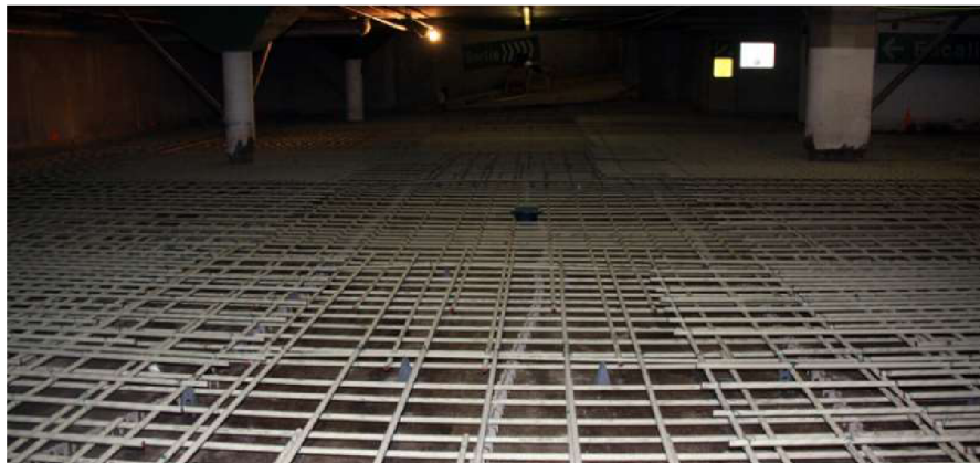
Obrázek 17 Vyztužení podlahy GFRP výztužemi v parkovacím domě, Quebec, Canada [77]
