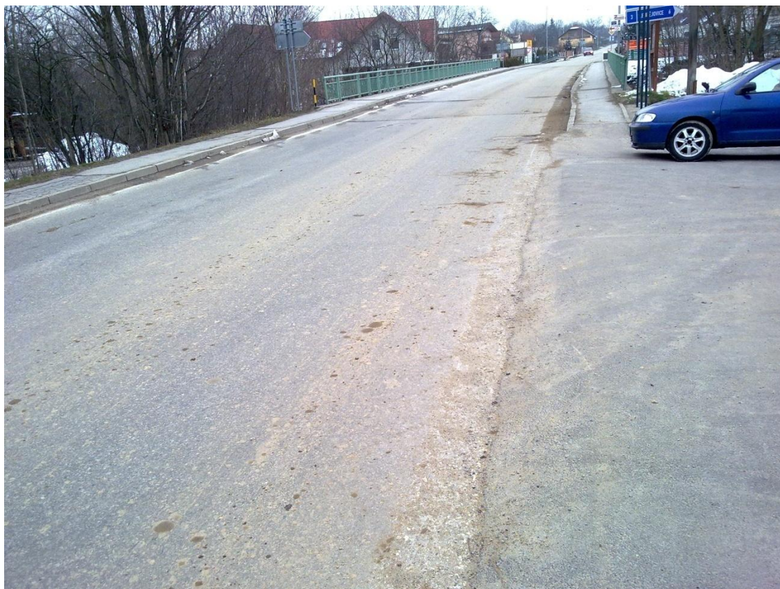
Obrázek 25 – Měřicí místo č. 4 – Silnice II. Třídy – Včelná – detail znečištěné komunikace
