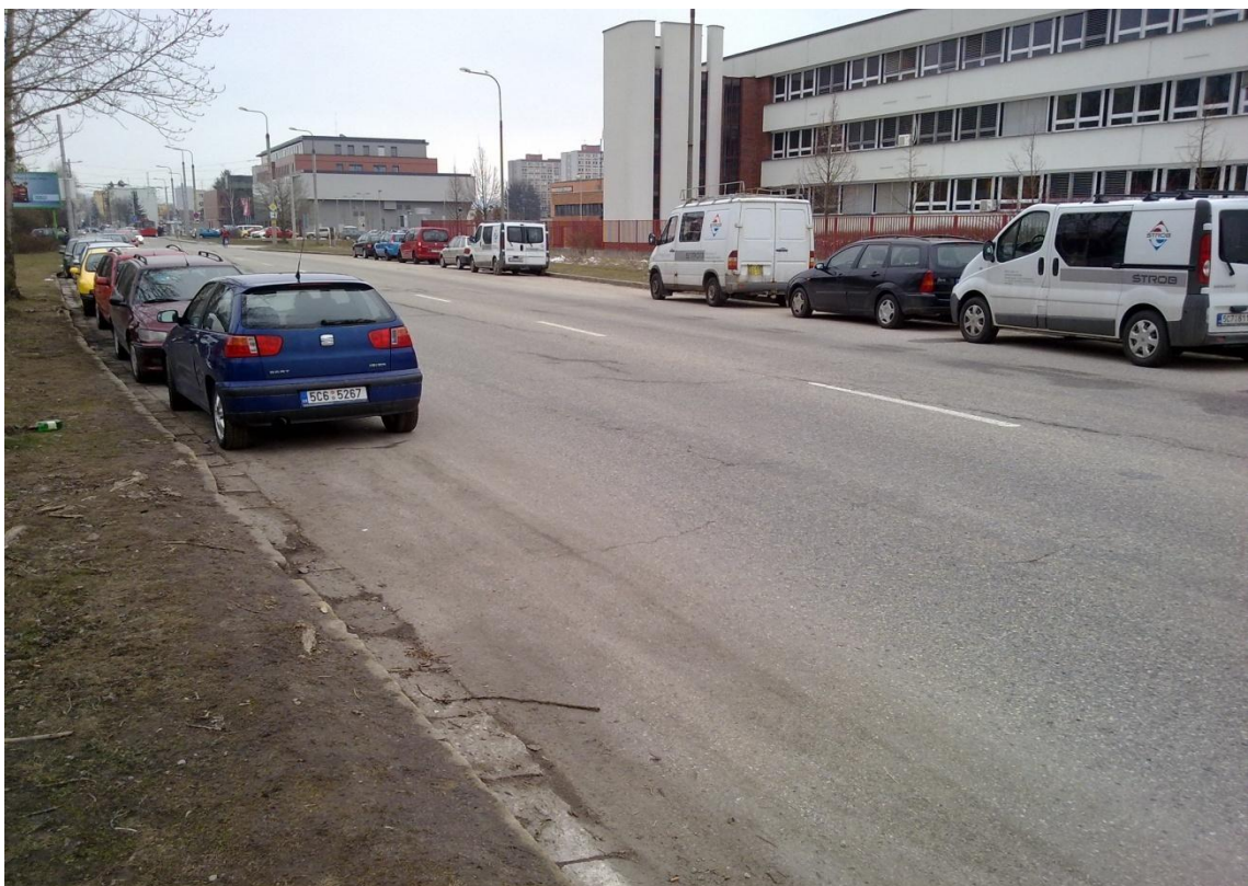
Obrázek 18 – Měřicí místo č. 2 – Branišovská ulice – Stavba areálu JČU – pohled na zaparkovaná vozila podél komunikace
