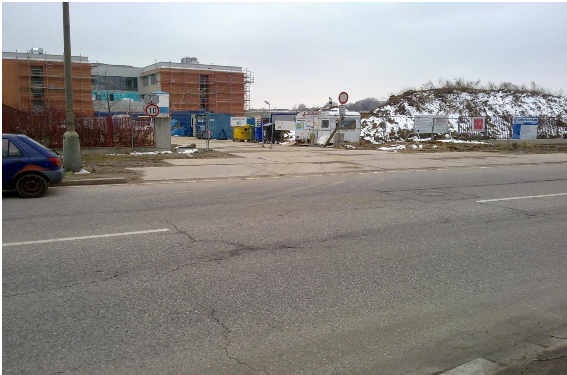
Obrázek 17 – Měřicí místo č. 2 – Branišovská ulice – Stavba areálu JČU – pohled na výjezd ze stavby
