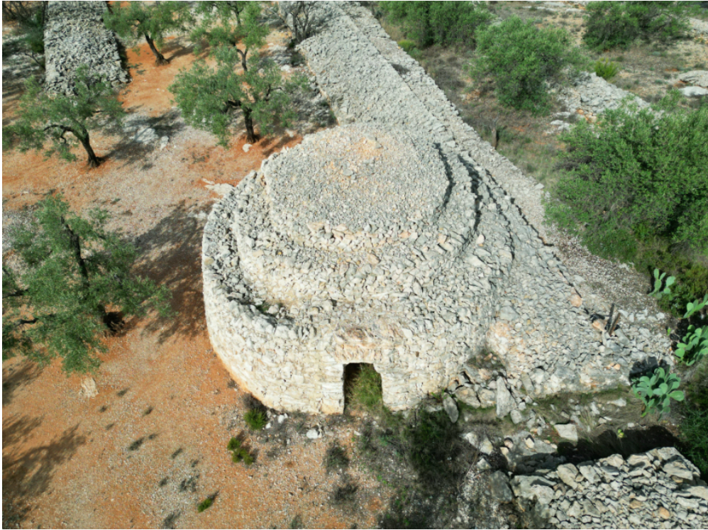
Figure 8. A dry-stone barrack (Mancomunitat Taula del Sènia)
