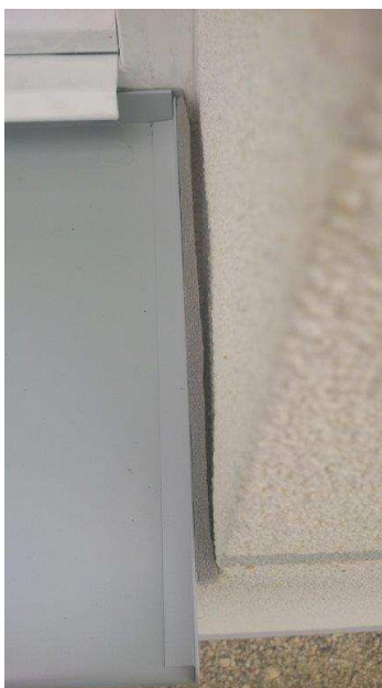
Obr. 10- chybně zvolená tloušťka komprimační pásky (5)
