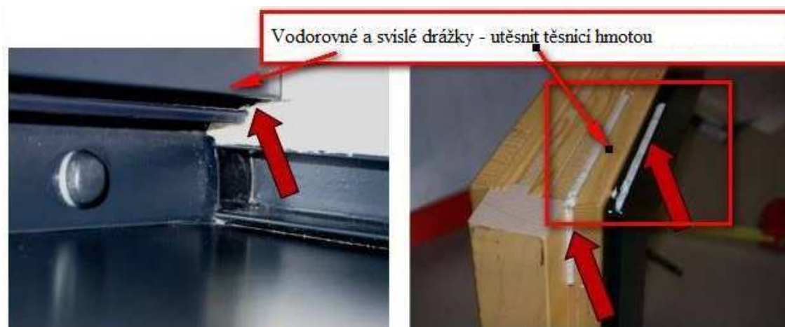
Obr. 20- Uzavření drážek v rámu okna a u ALU obkladu (4)
