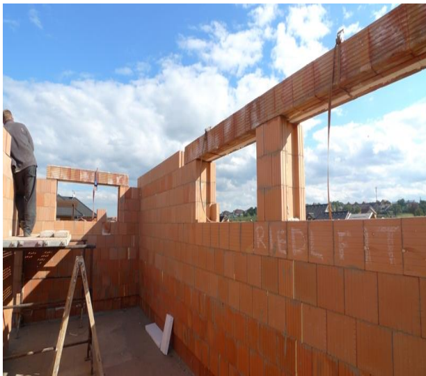
Obr.4.5 Uloženie prekladov
