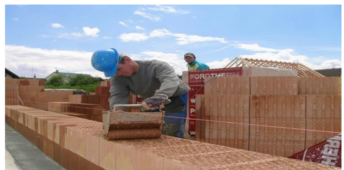
Obr.4.4 Murovanie 3. vrstvy za pomoci šnúrky
