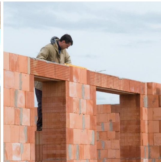
Obr.4.6 Domurovanie rady ku prekladom
