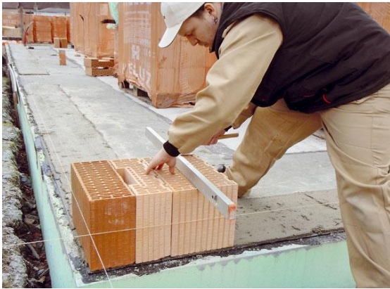
Obr.4.1 Založenie rohov
