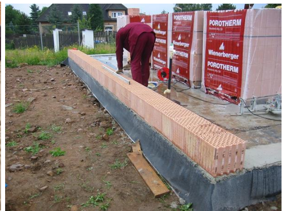
Obr.4.2 Založenie prvej rady
