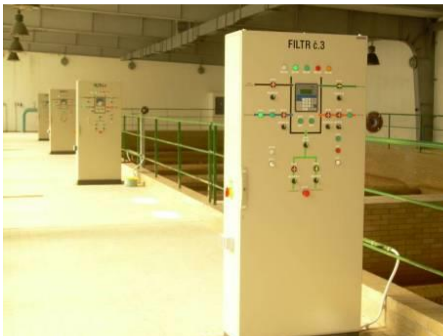
Obrázek č. 6: ovládací pult filtru (foto: J. Jánský 2014)
