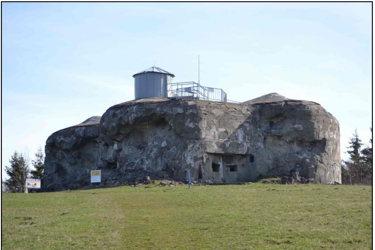
Foto 2: Pěchotní srub Můstek N-S 72
